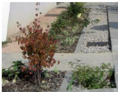
Infiltration des eaux pluviales dans des massifs végétaux et minéraux (gestion des pluies courantes + moyennes à fortes) (source : Grand Lyon)
