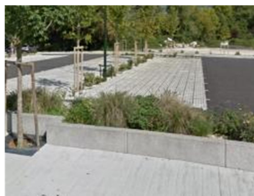
Infiltration des eaux pluviales à travers des stationnements poreux (gestion des pluies courantes + moyennes à fortes)
