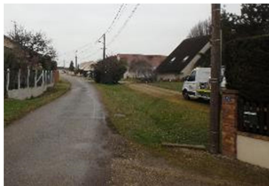
Infiltration des eaux pluviales de la chaussée dans une noue à Sassenay (gestion des pluies courantes et moyennes à fortes)
