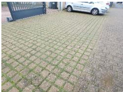
Infiltration des pluies courantes à travers un stationnement à joints poreux à Chalon-sur-Saône
