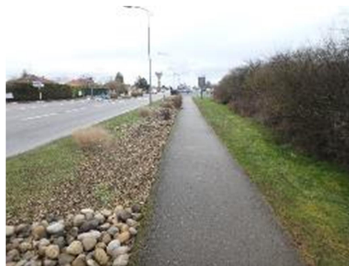
Infiltration des eaux pluviales de la chaussée et de la piste cyclable dans une tranchée, route d'Autun à Chatenoy-le-Royal (gestion des pluies courantes et moyennes à fortes)
