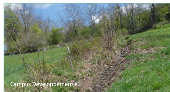
Vue d'un fossé situé en partie Sud du site
