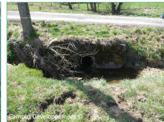
Vue d'un fossé servant d'écoulement pluvial
