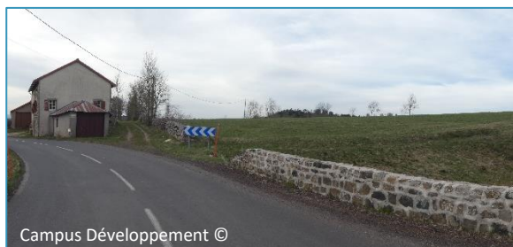
Vue du site depuis la Route Départementale n°38 en direction du Nord-Est
