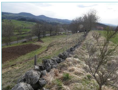
Vue sur le talus séparant la partie Nord de la partie Sud
