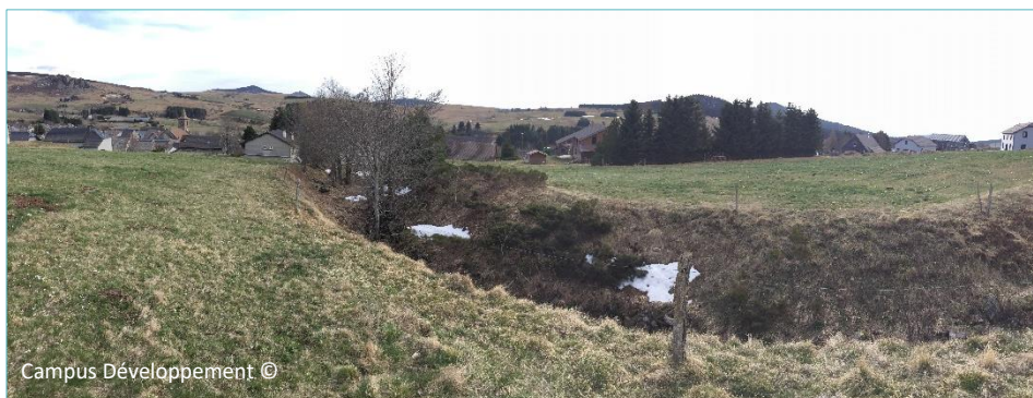
Vue sur la ravine qui divise le secteur de l'OAP
