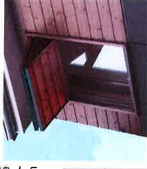
Une installation originale de volet coulissant faisant office de pare-soleil en position ouverte.
