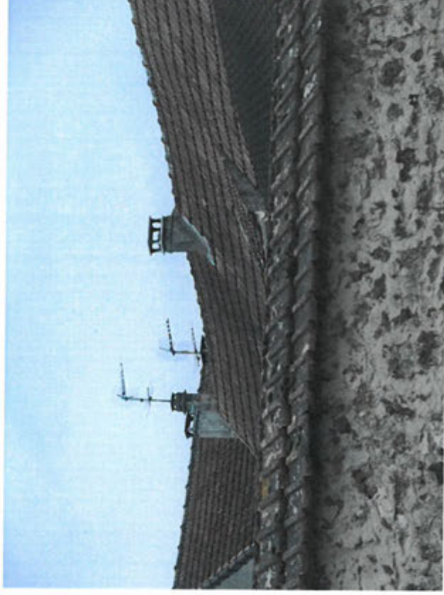
Couverture (chaperon) en tuiles, rejettent les eaux loin de la maçonnerie
