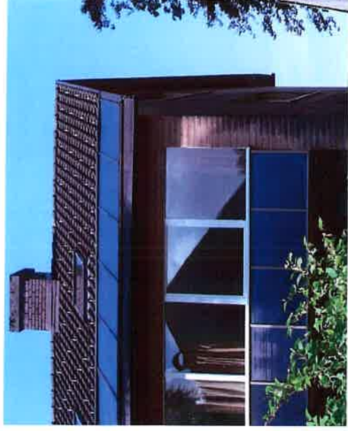
Les capteurs forment un bandeau horizontal qui prend appui sur la ligne d'égout du toit.
