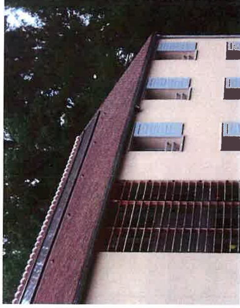
Une seule rangée de capteurs thermiques forme un ensemble simple qui souligne le faîtage de la toiture, se rapprochant du vocabulaire de la verrière.
