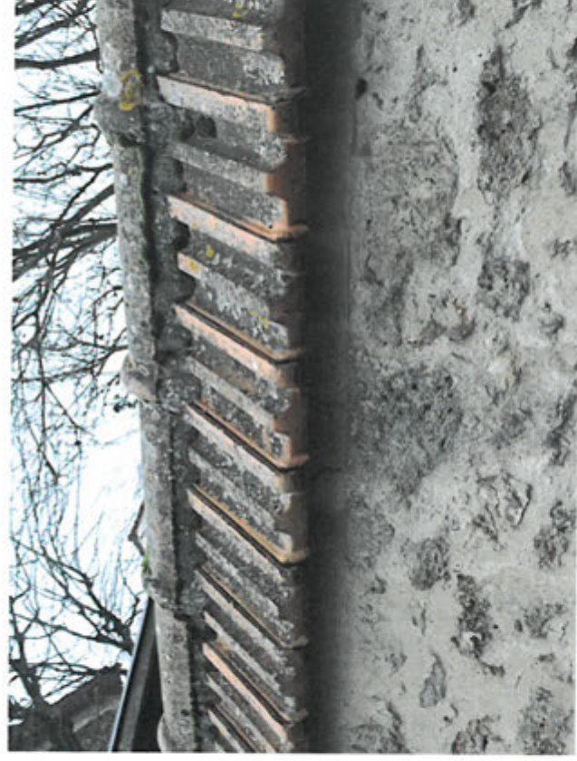
Couverture (chaperon) en tuiles, rejettent les eaux loin de la maçonnerie
