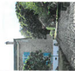
Allée perméable, pavés sur lit de sable
