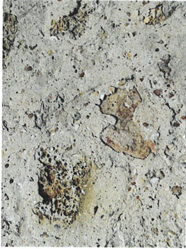
Enduit à pierres vues, non uniforme, sable et gravillons colorés
