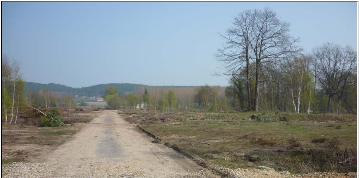
Secteur ouest en cours de dépollution
