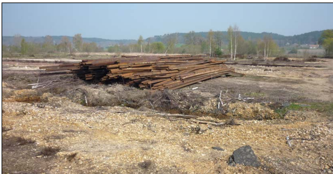
Secteur ouest en cours de dépollution
