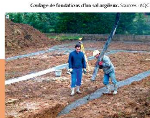
Contage de fondations d'un sol argileux. Sources : AOC
