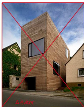
Chambre d'Ebeling d'Archifactory 2000-2001 à Dortmund en Allemagne
