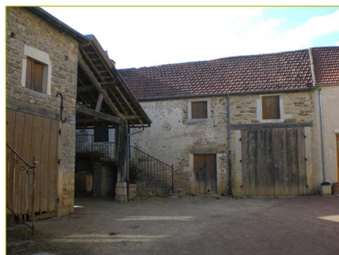
Bâtiment agricole ancien
