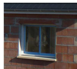
Fenêtre avec tablette non traditionnelle
