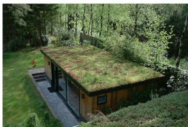
Toiture terrasse végétalisée
