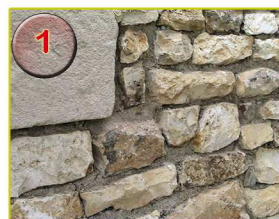
Mur en pierre non jointoyé
