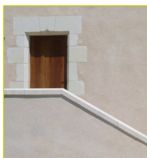
Enduit au nu des pierres d'encadrements
