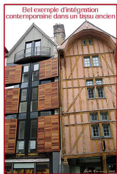
Immeuble commerces et Logements 2002, Rue Emile Zola à Troyes
