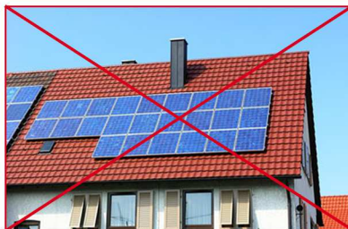
Eviter le placement désordonné des panneaux solaires
