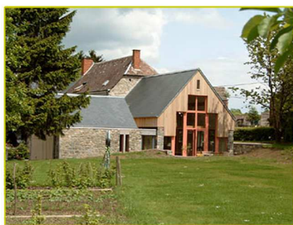
Extension de la Maison Waha, Architecte Jaspard, Belgique
