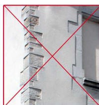
Enduit en surépaisseur
