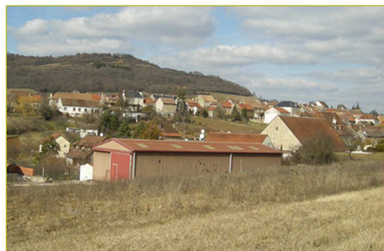
Bâtiment agricole bien inséré dans son environnement
