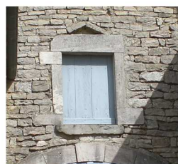
Fenêtre avec tablette traditionnelle
