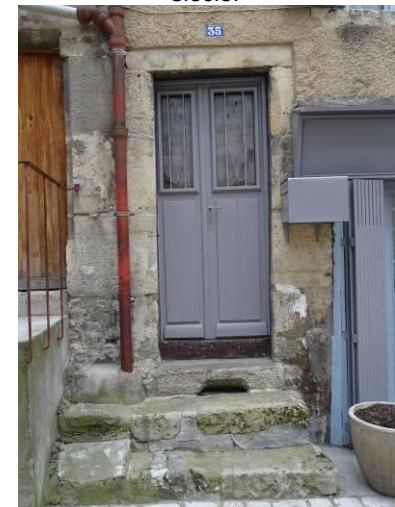
Rue Notre-Dame. Emmarchement extérieur en pierre dans lequel s'ouvre le soupirail de la cave.
