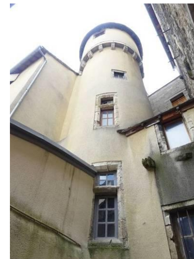
Rue d'Aigues-Passe. Tour d'escalier semi hors-œuvre.
