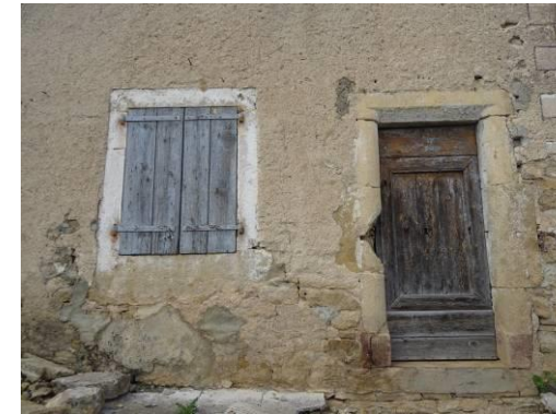
Chabrits, Un enduit de chaux et de sable couvre le parement moellonné.
