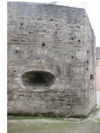
Tronçon de l'enceinte médiévale et bastion, place Théophile Roussel. Détail sur l'une des canonnières du bastion. A droite, en bas, plan du bastion. Détail du plan Barrier, 1889, AM.
