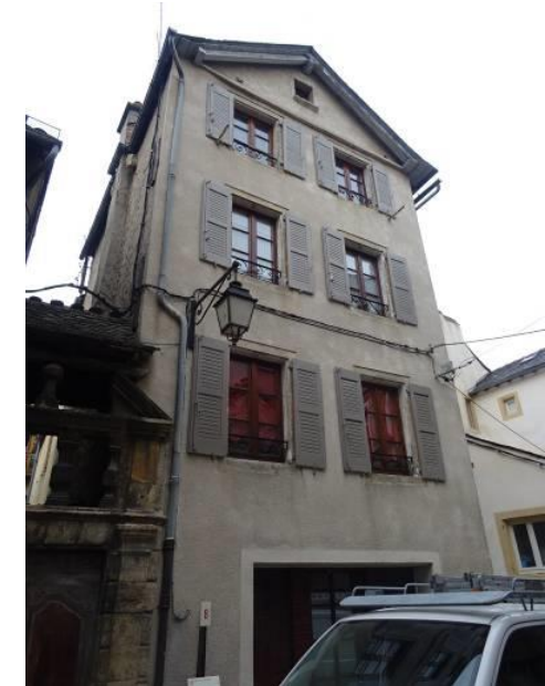
Rue de la Jarretière. Maison des 15 e – 16 e siècles remaniée au 19 e siècle.
