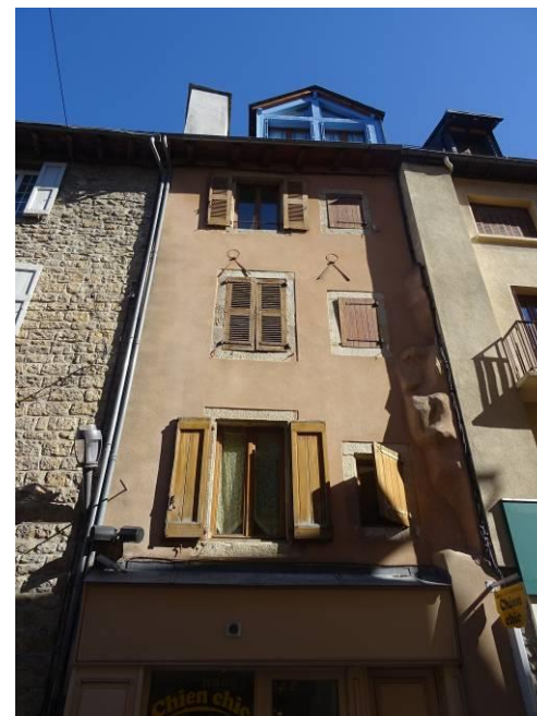
Plan de la ville de Mende. 1814 ? STAP. Détail sur la porte d'Angiran. A droite, la maison 5, rue d'Angiran sans doute construite sur l'emprise de l'ancienne porte d'Angiran dont les vestiges apparaissent sous la forme d'un arrachement de maçonnerie (à droite).
