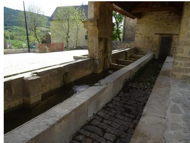
Chabrits, le lavoir de 1879. Vue des bassins
