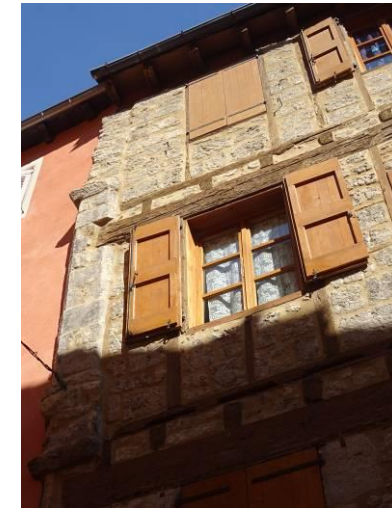
Rue d'Angiran. Façade des 15e – 16e siècles dont le pan de bois en encorbellement (présence du refend) a été mis en recul ultérieurement (17e – 18e siècles ?)
