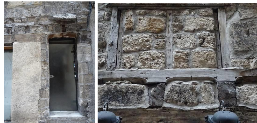
Rue Notre-Dame. La sablière de chambrée et le pan de bois de l'étage de la seconde moitié du 15e siècle – début du 16e siècle, à l'origine en encorbellement sur la rue, ont été déplacés en retrait. Le hourdis se compose de moellons équarris en travertin.
