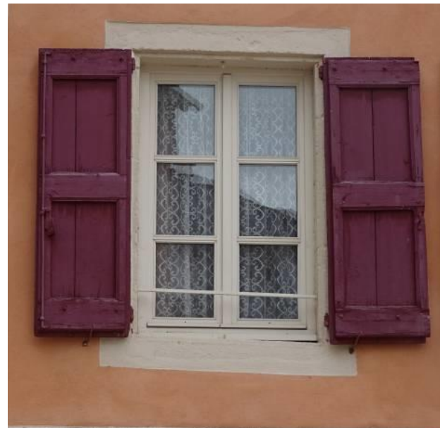
Rue de l'Abbaye. Contrevents en bois à lames larges et intérieur à cadres. 19e siècle.
