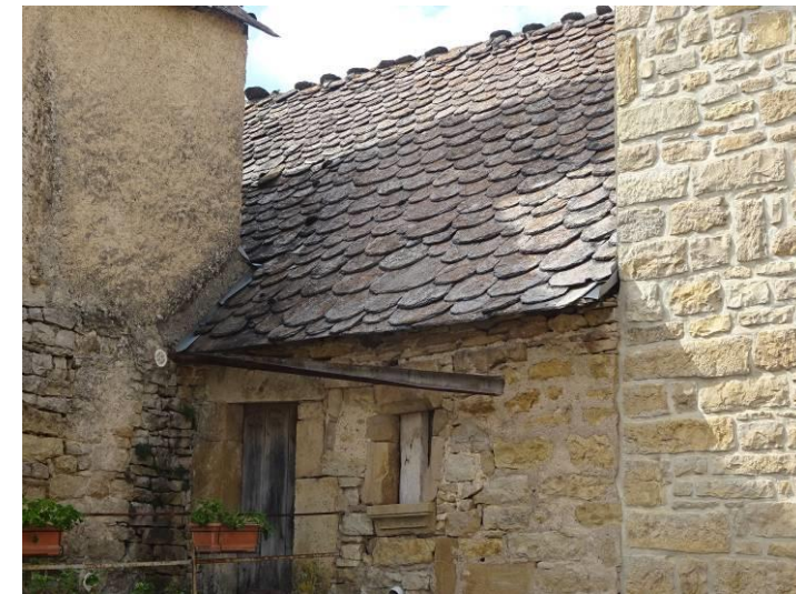
Chabrits. Couverture à deux pans en lauzes de schiste à lignolet croisé.
