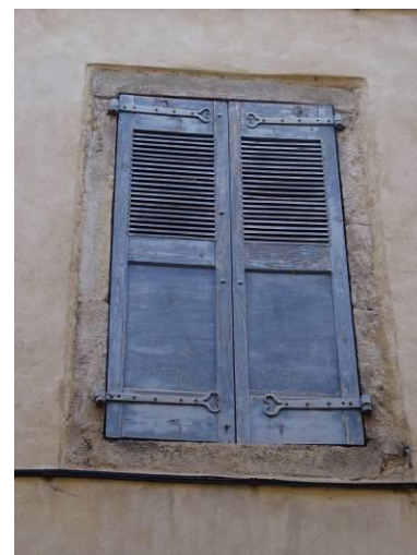
Rue Basse. Fenêtre du 19e siècle.
