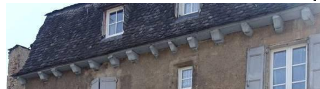
Rue d'Angiran. 15e – 16e siècles. Abouts de solives d'avant-toit profilés de chanfreins et de congés en cuiller.
