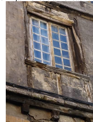
Rue de l'Epine, fenêtre à meneau. La division en bois a été supprimée au 18e siècle au profit d'une menuiserie à la française à deux battants à petits carreaux
