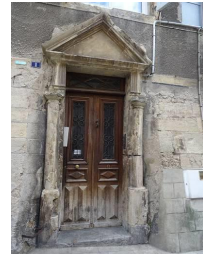
Rue de l'Arjal. Porte du 17e siècle sous fronton triangulaire en encadrée par deux colonnes à chapiteaux toscans.
