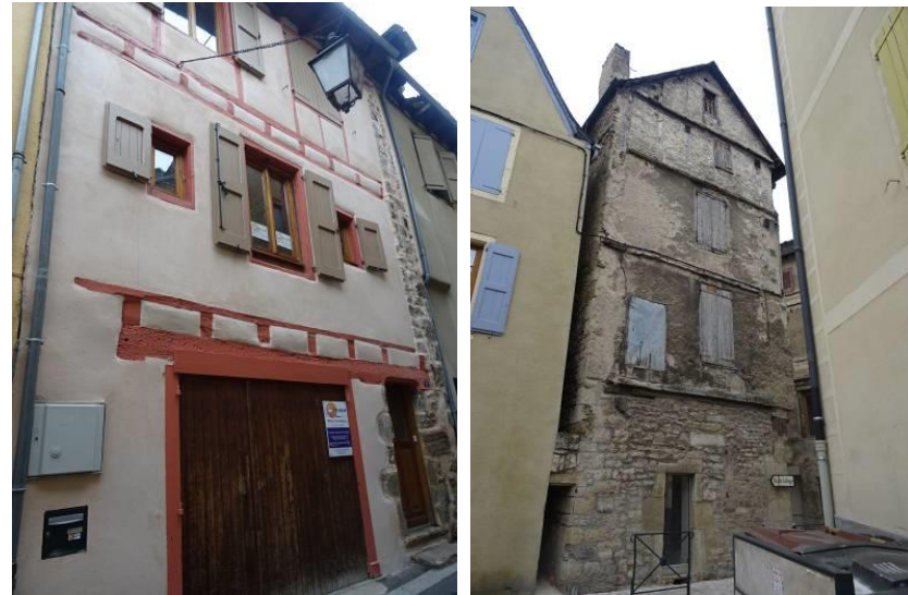
Rue des Finets. 15 e – 16 e siècles. Le pan de bois des étages, à l'origine en encorbellement, a été disposé dans le plan du rez-de-chaussée. A droite, maison rue du Collège. Façade pignon de la seconde moitié du 15 e siècle – début 16 e siècle.
