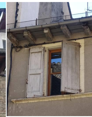
Rue d'Angiran. 15e – 16e siècles. Abouts de solives d'avant-toit profilés de chanfreins et de congés en cuiller.
