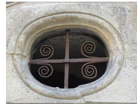
Rue d'Angiran. Œil de bœuf et sa ferronnerie en volutes. 16e – 17e siècles ?
