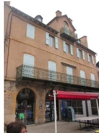
Boulevard du Soubeyran, garde-corps du 19e siècle.
