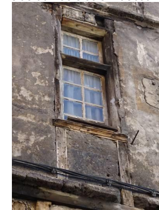
Rue de l'Epine, fenêtre à traverse.
