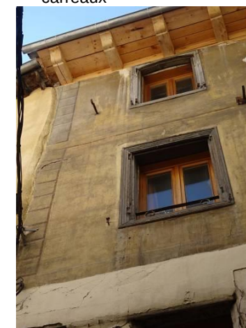
Rue d'Angiran. « Lindages » de fenêtres moulurées. Cadre en bois fixé sur le tableau en bois de l'ouverture contre lequel s'appuie l'enduit de façade
