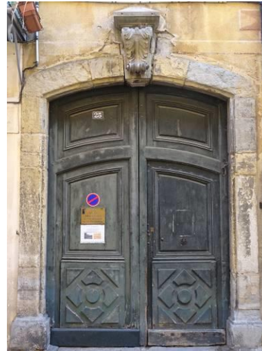
Rue Basse. Portail du 18e siècle.
