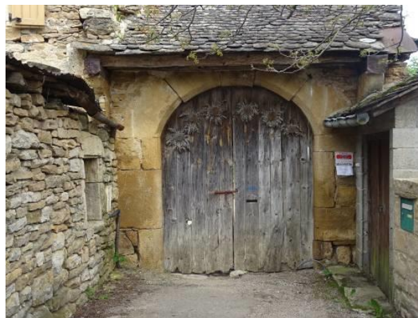
Chabannes. Porche sous couverture de lauzes.
