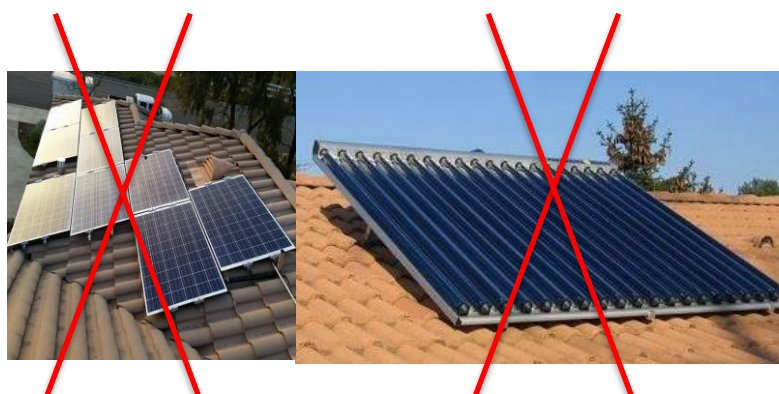
Implantations interdites : implantations anarchiques et/ou en surinclinaison
