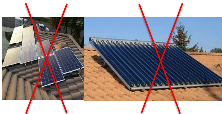
Implantations interdites : implantations anarchiques et/ou en surinclinaison
