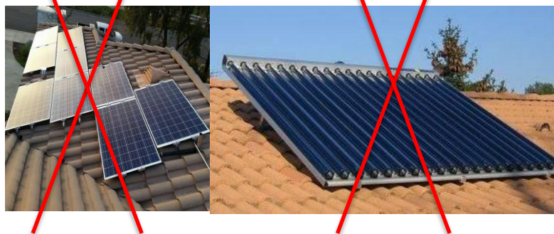
Implantations interdites : implantations anarchiques et/ou en surinclinaison
