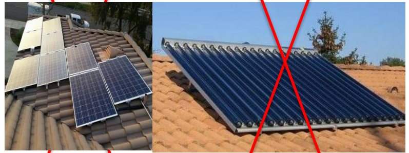
Implantations interdites : implantations anarchiques et/ou en surinclinaison
