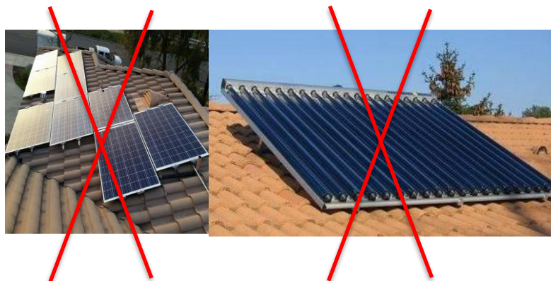
Implantations interdites : implantations anarchiques et/ou en surinclinaison
