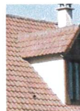
Lucarne à deux pans en bâtière sans rebord en façade
