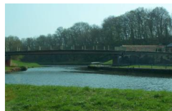
Déversoir et pont à Vénérolles
