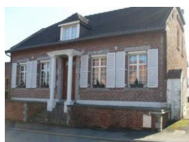
Maison rurale dénaturée par un auvent à colonnes
