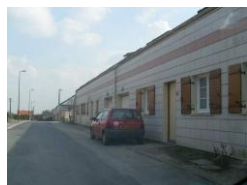
Habitat collectif volumétrie, percements et matériaux inadaptés
