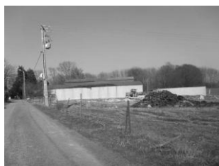
Continuité visuelle inexistante
