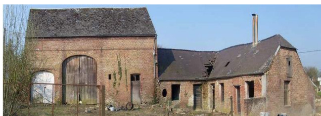
Ferme typique de Thiérache qui mérite une réhabilitation
