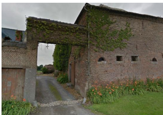
Ferme de Wassigny (13 rue de la Gloriette)
