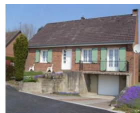
Construction pavillonnaire sur sous-sol apparent
