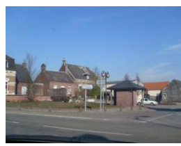
Traitement de carrefour
