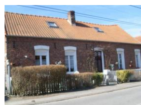
Longère en briques avec toiture en pannes flamandes
