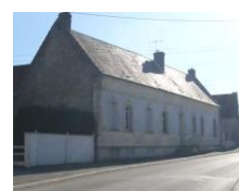
Longère revêtement en ciment et modénature en pierre de taille
