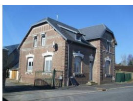
Maison 1900 avec toiture à croupe et modénature briques
