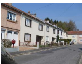
Maisons de ville accolées enduit clair, absence de modénature percements plus hauts eu larges
