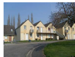
Maisons de ville accolées enduit trop clair, sans modénature
