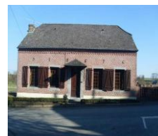
Maison typique de Thiérache avec toiture à croupe tronquée sur un pignon
