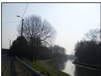
Le canal à Etreux, parallèle à la voie
