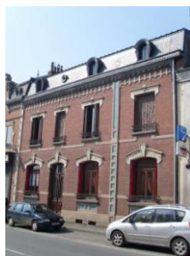
Maison de ville à étage en briques à modénature en pierre et décor de céramique
