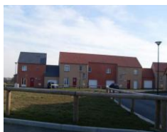
Habitat collectif bonne volumétrie enduit ton brique modénature inexistante
