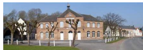
Place publique aménagée sommairement : principalement un stationnement
