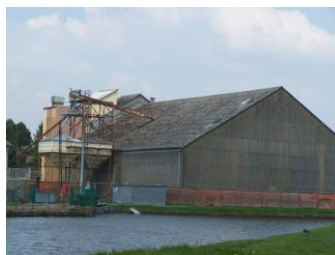
Des installations de type silo, hangar, ont gagné les bords du canal, de façon à intégrer le transport fluvial des marchandises
