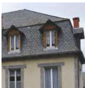
Les terrassons en pente moyenne, visibles depuis l'espace public seront refaits en ardoise. (Raccord brisis-terrasson en ardoise)
