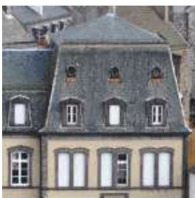
Les terrassons en faible pente, peu visibles de la rue, pourront être refaits en zinc. (Raccord brisis-terrasson en bande de métal)
