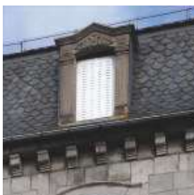
Les terrassons en faible pente, peu visibles de la rue, pourront être refaits en zinc. (Raccord brisis-terrasson en bande de métal)
