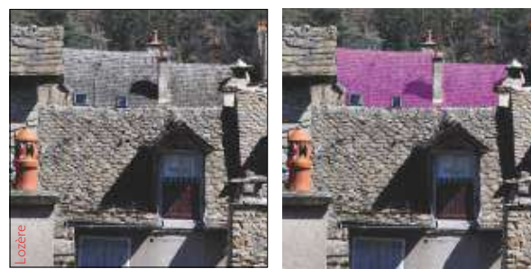
Le bardeau de châtaignier peut, sous certaines conditions, se révéler un substitut à la lauze.
