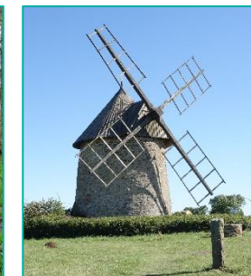
Moulin à vent, Celoux
