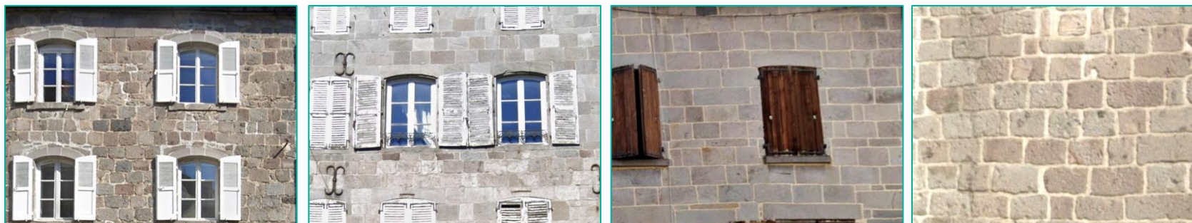
Différentes façades en pierre appareillée et à joints plus ou moins fins à Murat - web
