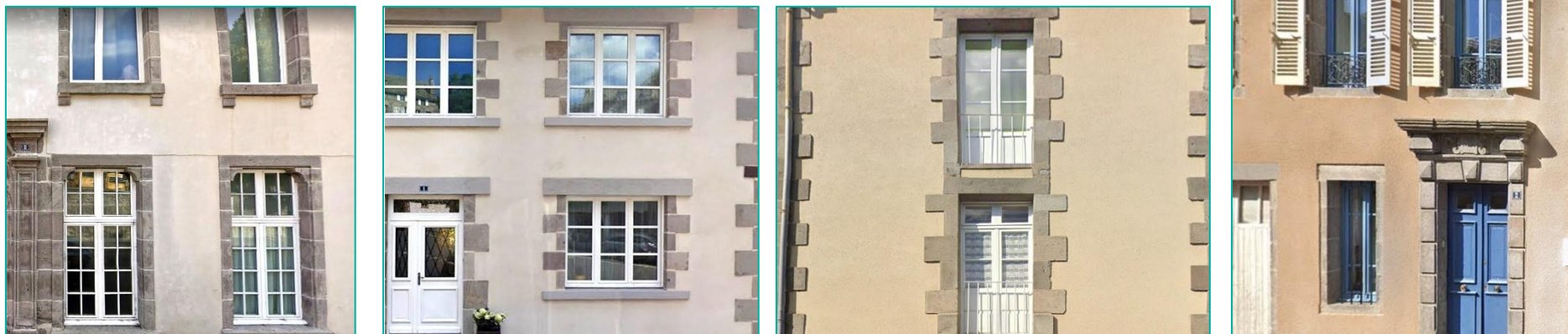
Différents enduits à Murat - web
