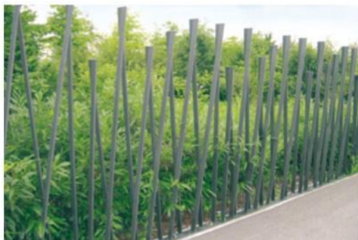
Travail d'une clôture métallique
