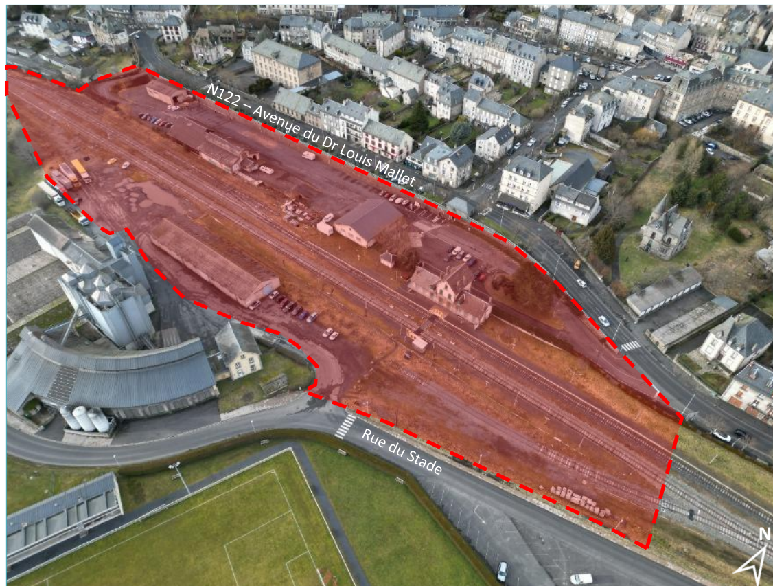
Prise de vue aérienne du secteur de la Gare de Murat - © Campus Développement
