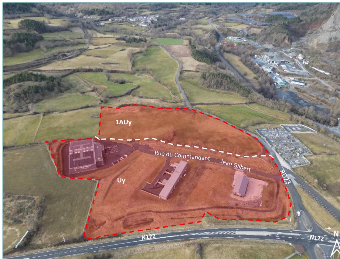
Prise de vue aérienne du secteur "Les Canals" - © Campus Développement
