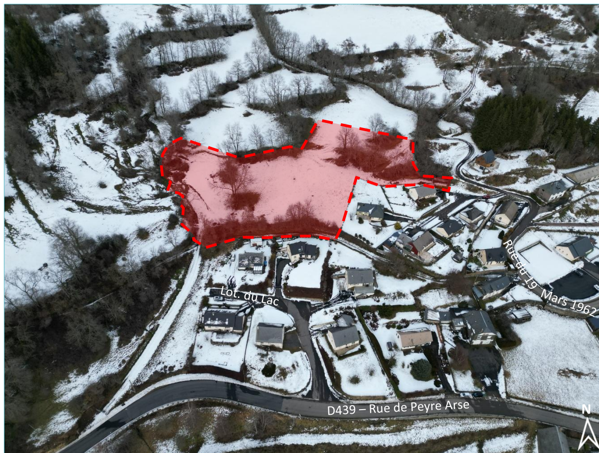
Prise de vue aérienne du secteur "Les Blates" - © Campus Développement
