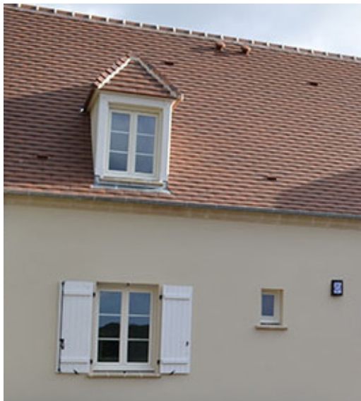
Fenêtres à six carreaux et volants à deux battants ouvrant à la française.
