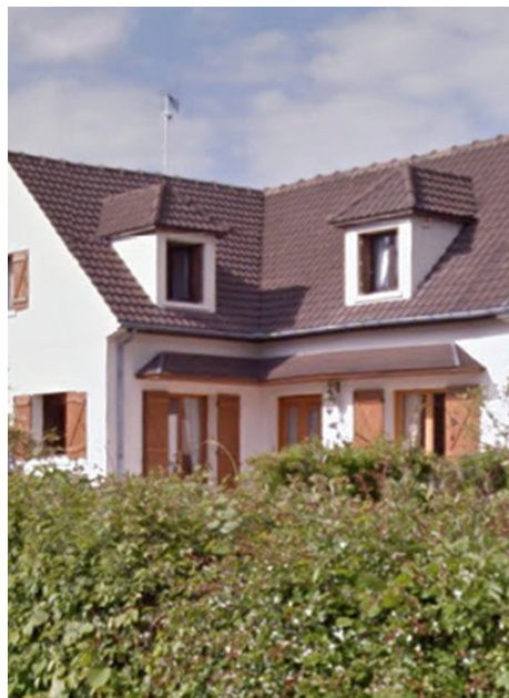
Toiture à deux pans, tuiles mécaniques.
