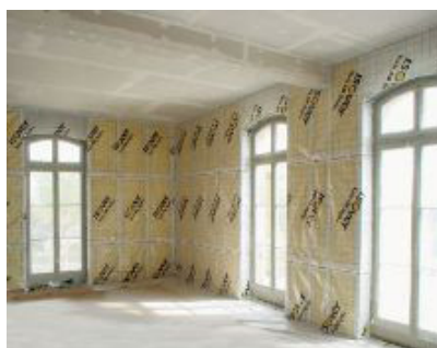
Isolation des murs par l'intérieur.
