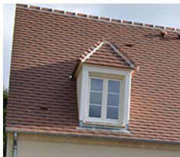
Lucarne à capucine avec jouée enduite.
