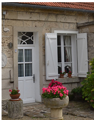
Porte avec vitrage et imposte ; fenêtre à 6 carreaux.
