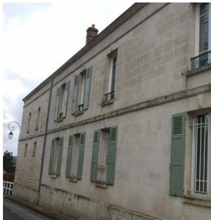
Façade en pierre de taille avec bandeau et soubassement en relief à conserver.
