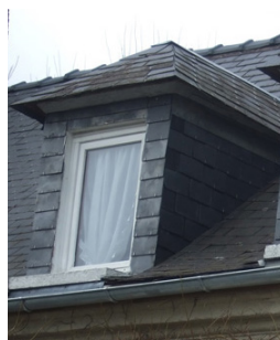
Lucarne dite à capucine avec jouée en ardoise.
