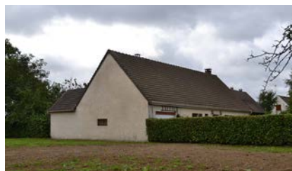
Extension de la construction principale à l'arrière de cette dernière : à privilégier.
