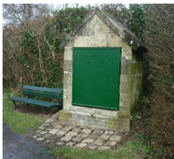
Ancien puits situé sur la ruelle rouge, qui nécessite d'être préservé et valorisé.
