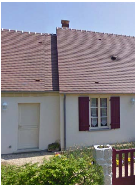
Toiture à deux pans, petites tuiles plates.
