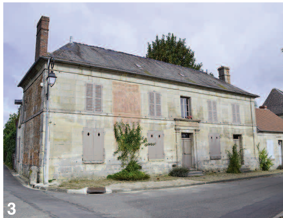
3 et 4 : Vue sur l'ancienne maison de commerce
