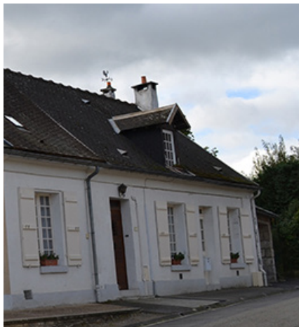
Toiture à 2 pentes à 45° et couverture en ardoises.
