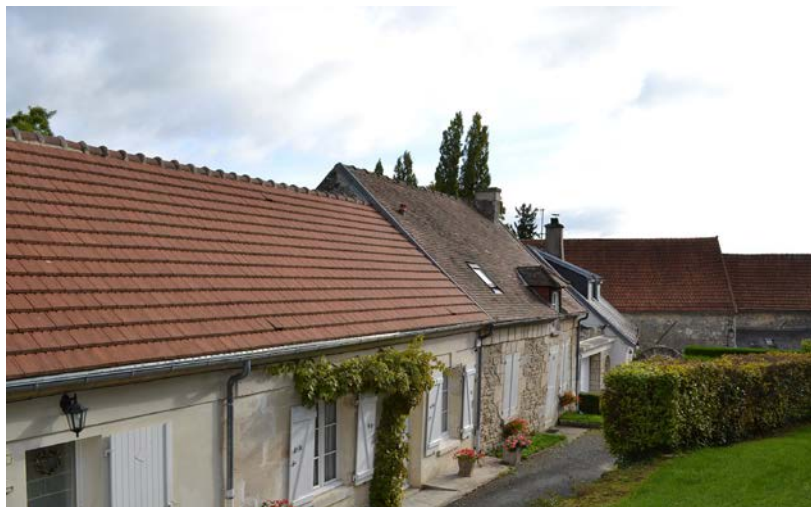
Hauteurs des constructions homogènes malgré le dénivelé du terrain.
