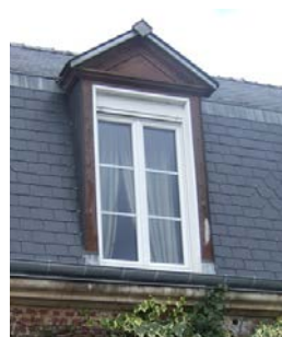
Lucarne dite jacobine en ardoise avec montant en bois.
