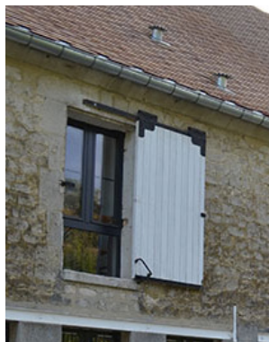
Fenêtre en aluminium teintée utilisée en réhabilitation du vieux bâti.
