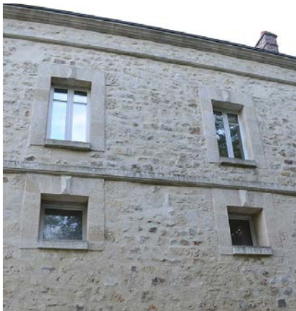
Façade en moellon avec encadrement des ouvertures en pierre de taille à conserver.
