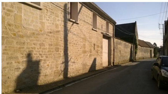
Murs de façade ravalés
