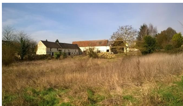
Corps de ferme sur le point d'être réhabilité rue du Prieuré
