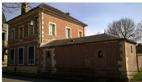
Ecole rue de la Mare du Bois
