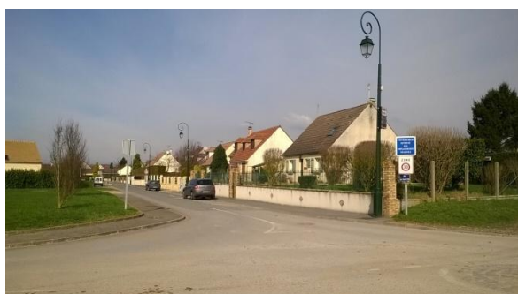
Pavillons rue des Quatre vents
