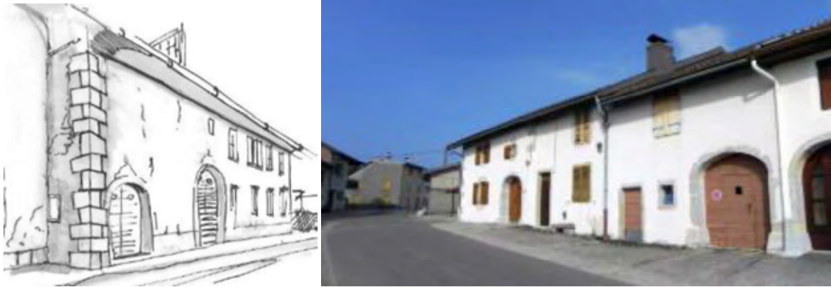
Figure 168 : Portes de granges en anses de panier, chaînes d'angles en pierre de taille (fermes en bande à La Mouille)
