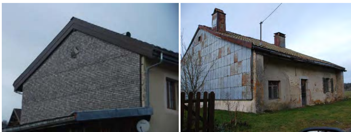
Figure 167 : Bardages bois et métalliques sur des murs pignons à Bellefontaine et à Morbier
