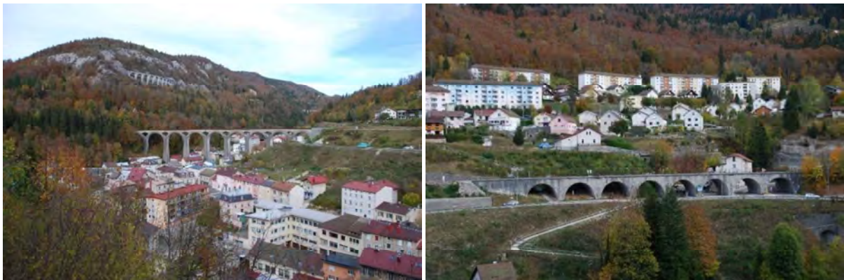
Figure 183 : Viaducs de la ligne des hirondelles à Morez et Morbier
