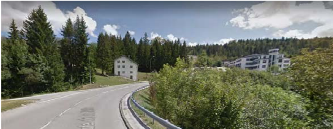
Figure 126 : Entrée de village ouest de Morbier
