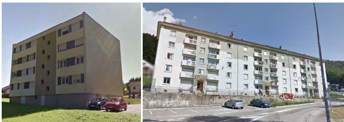
Figure 191 : Immeubles de logement à Longchaumois et à Villedieu à Morez
