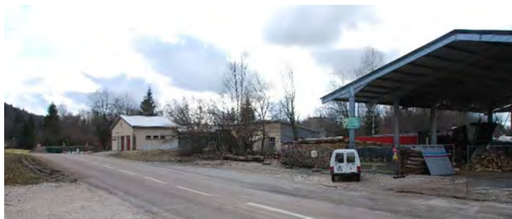
Figure 75 : Vues de la zone d'activités de La Mouille depuis la route D69
