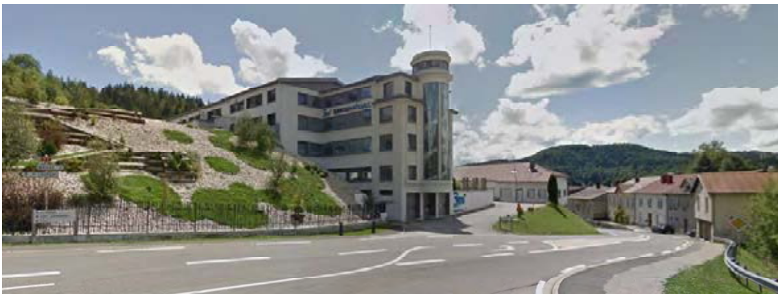
Figure 127 : Entrée de village ouest de Morbier (arrivée sur la RN5)
