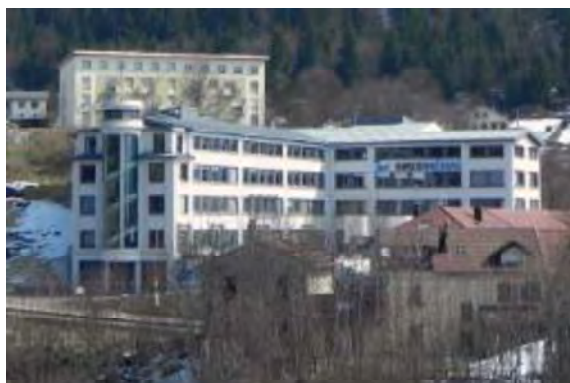
Figure 181 : Immeuble-atelier à Morbier
