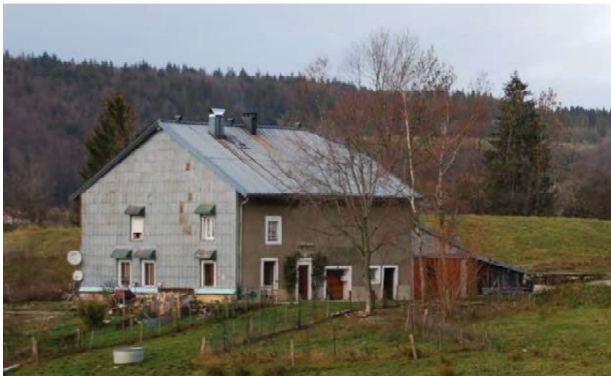
Figure 166 : Ferme isolée à Bellefontaine : bardage zinc, ouvertures et auvents sur façade pignon, enduit à la chaux sur façade principale
