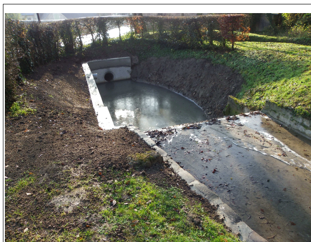
Figure IV.4: Bassin de rétention situé dans le bourg de Morienvall
