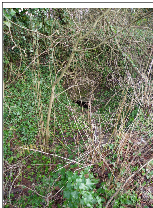
Figure IV.11: Entrée secondaire de la carrière de la Croix Rouge
