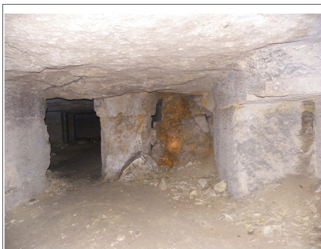
Figure IV.27: Couloir entre deux salles de la carrière
