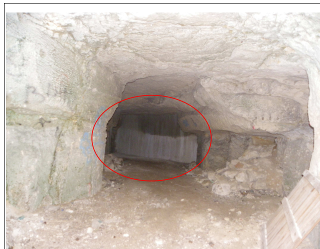
Figure IV.19: Intérieur de la carrière de la Couture ; en rouge, le mur de contention établis après les travaux de réhabilitation de la RD163
