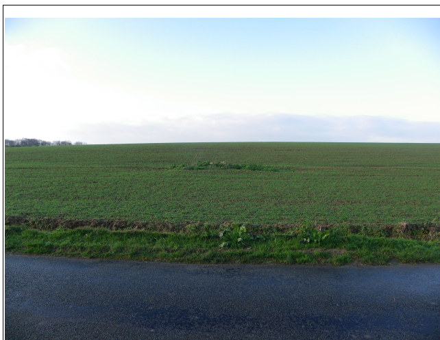
Figure IV.13: Puits d'aération de la carrière de la rue Edmond Lebee
