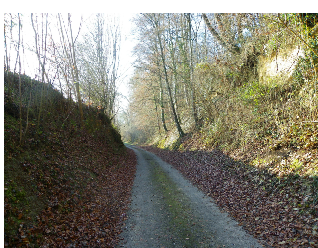
Figure IV.10: Route en déblais à Rocquigny
