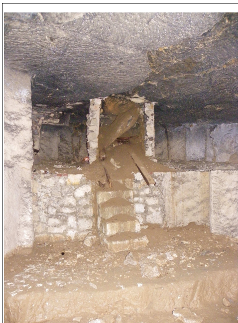
Figure IV.23: Escalier et cheminée obstruée
