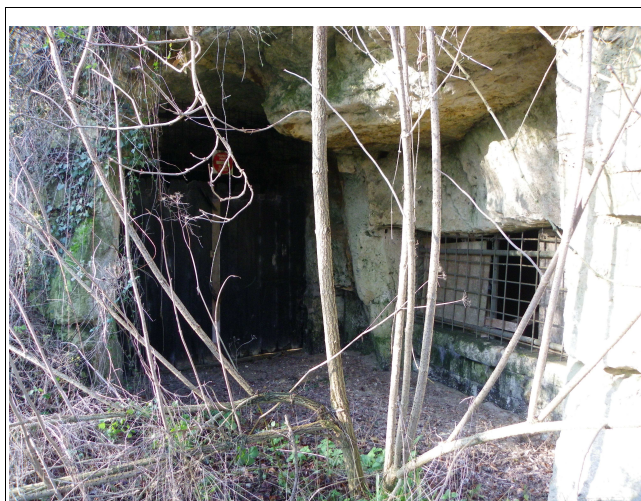
Figure IV.34: Entrée de la première carrière de Buy
