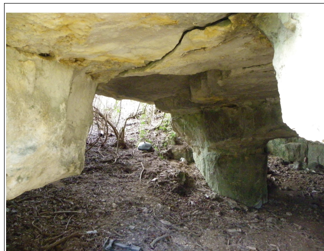
Figure IV.36: Entrée de la seconde carrière, toit fracturé et effondrement du fond de la carrière
