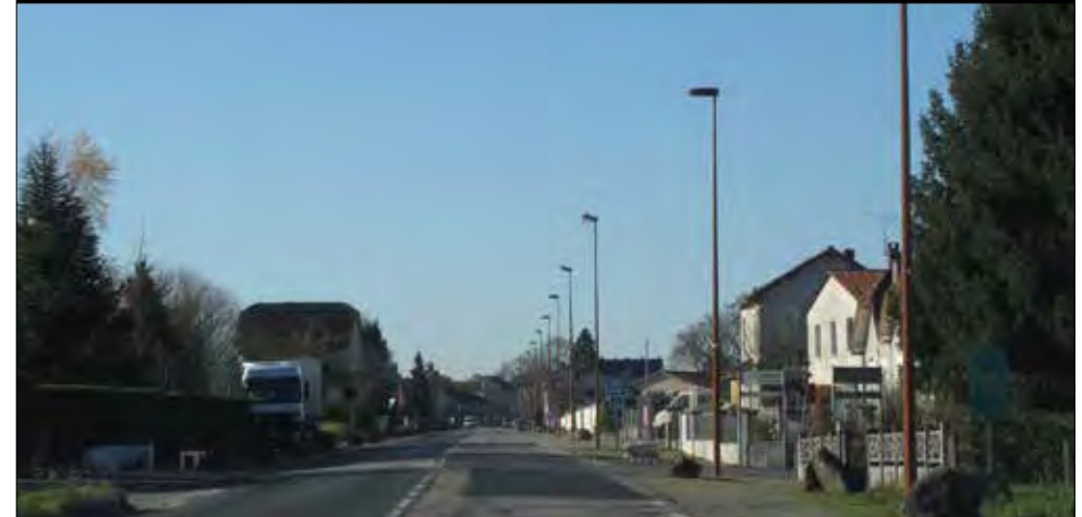
CARACTÈRE ROUTIER DE LA RD 951 SUR L'AVENUE DE BELLAC
