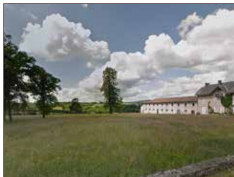
▲ Point de vue sur l'entrée Est de Berneuil (PDV_2)
