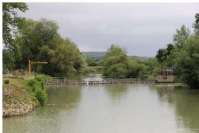
Barrage à Vouziers (source AUDRR)
