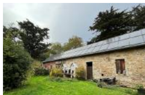
Toiture photovoltaïque, Douarnenez. © Fabien Sénéchal (ANABF)
