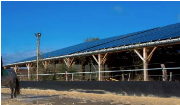
Hangar à Roche (38). © Wolfgang Borst
