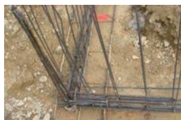
Nœud de chaînage - Continuité mécanique
