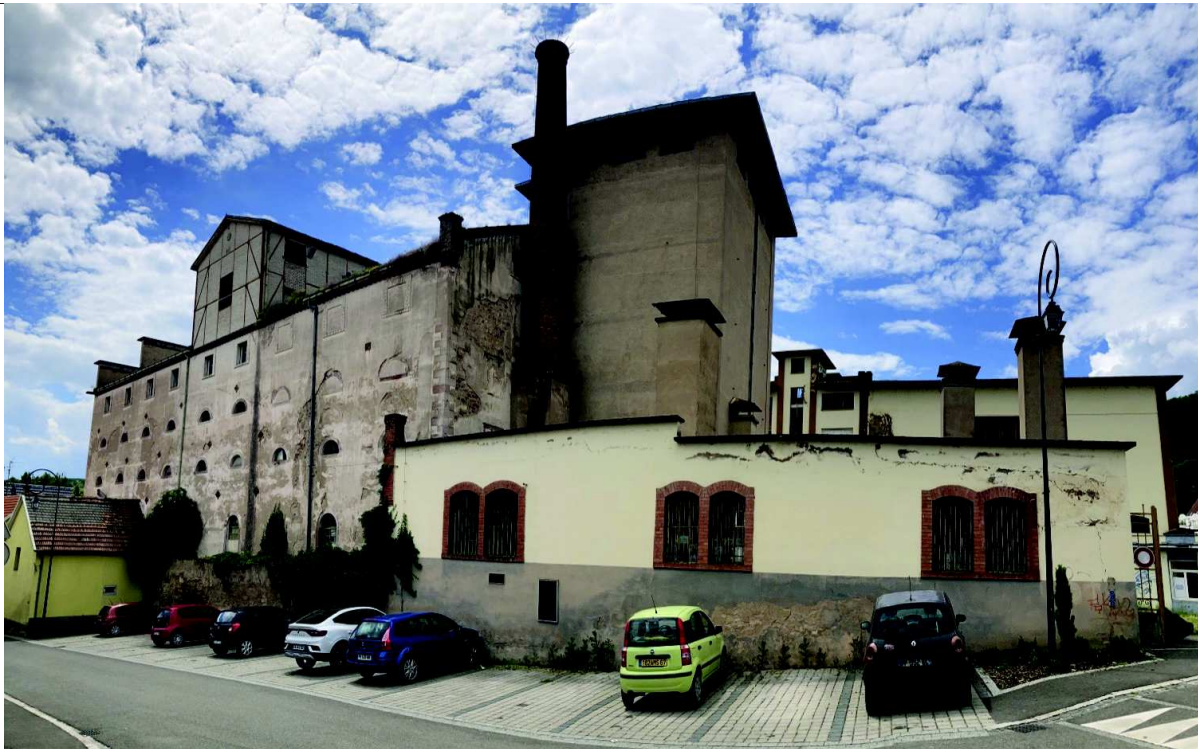
Illustration 4 : Vue panoramique vers l'Ouest – arrière de la brasserie – Source ARCHIMED Environnement – 12/06/2024 - Fig. 1
