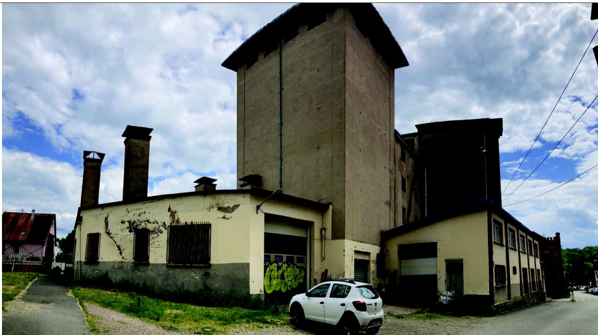
Illustration 5 : Vue panoramique vers le Sud – partie Nord du site – Source ARCHIMED Environnement – 12/06/2024 - Fig. 2
