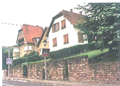
Rue de la Trinité - villas et murets de soutènement
