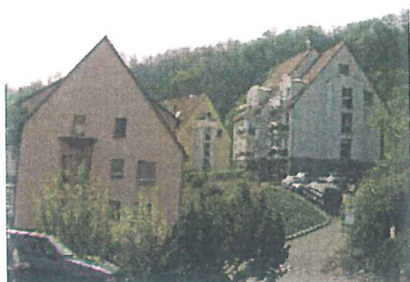
Chemin de la Forêt - immeubles collectifs des années 1980-1990
