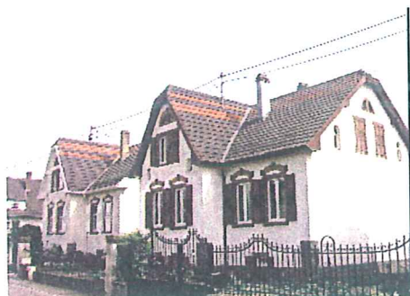
Anciennes maisons ouvrières à Hermolsheim - rue des Muguet
