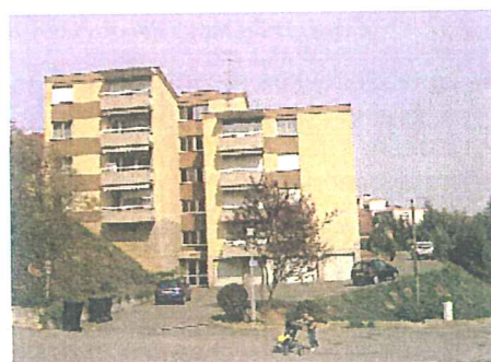
Chemin de la Forêt - immeubles collectifs des années 1970
