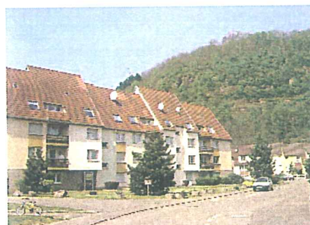
Vorfelsbourg - immeubles collectifs du début des années 1980
