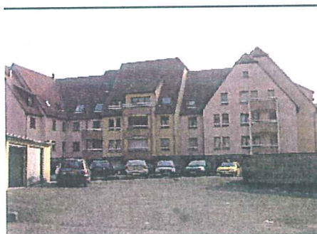
Impasse Sainte Barbe - immeubles collectifs des années 1980 dans le centre ancien
