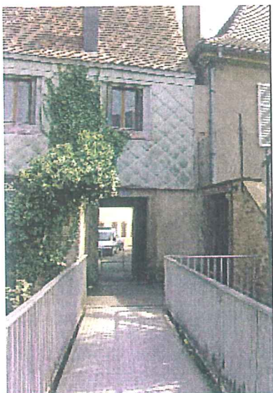
La passerelle sur la Bruche devant à l'entrée Hermolsheim - vue du passage du Couvent.
