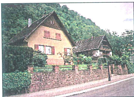
Boulevard Clémenceau - années 1970-80 (utilisation de murets de soutènement en grès)
