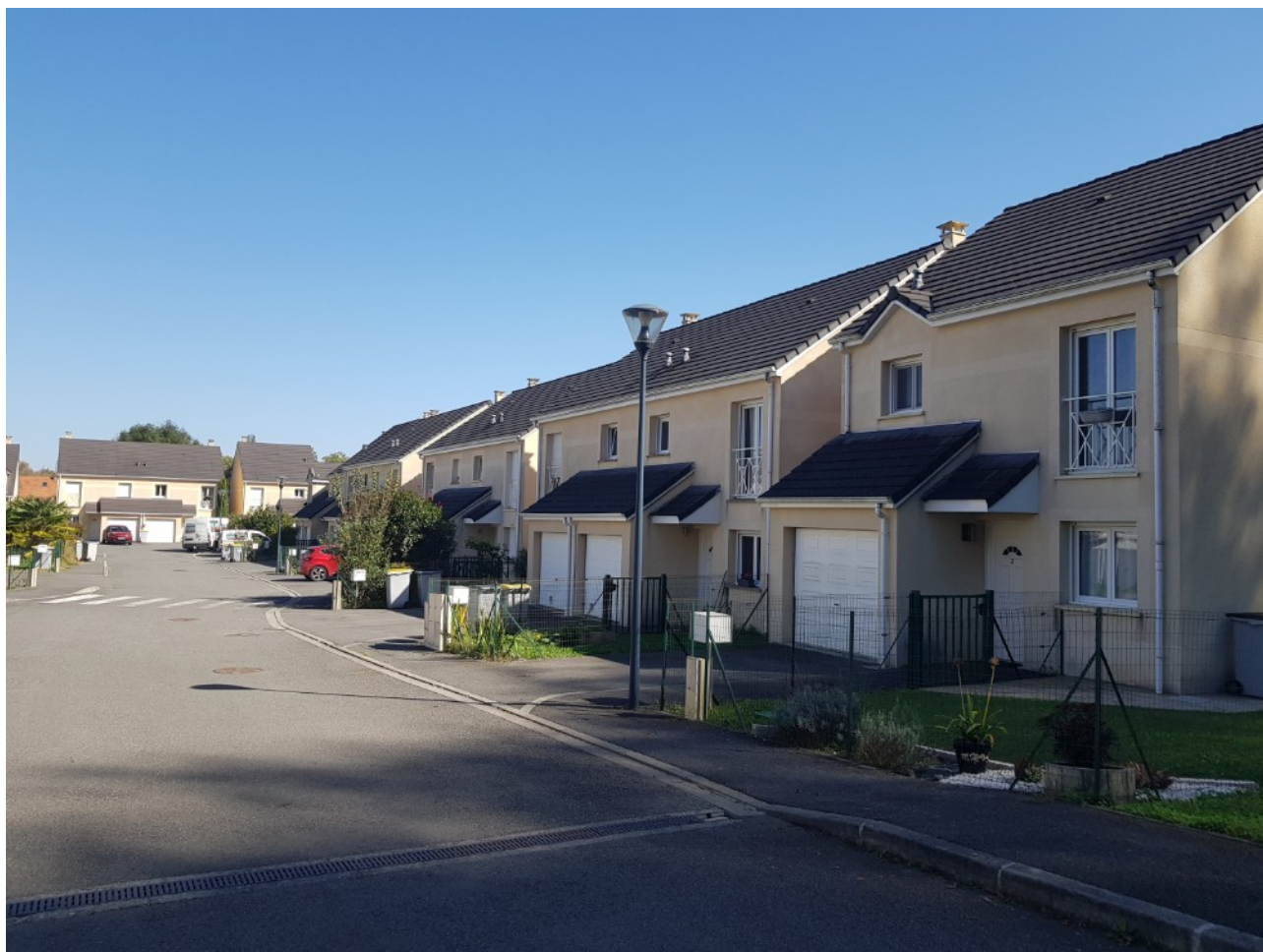
Logements rue de la Colline
