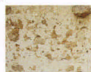
enduit sur moellon
