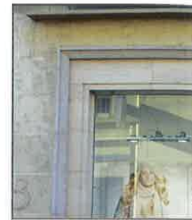
Encadrement en béton d'une baie en feuillure
