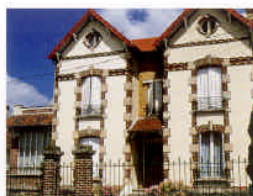
modénatures : céramiques, bandeaux, corniches, harpes, encadrements
