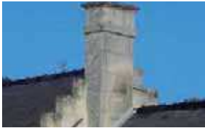
Souche de cheminée en pierre de taille
