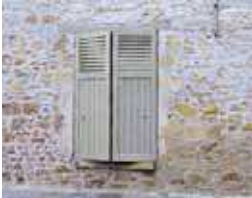
Maçonnerie moellon à pierre vue
