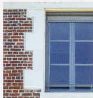
ravalement de mur de brique, joints à la chaux avec un appareillage panerisse/boutisse, occultation par un store intégré
