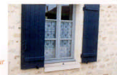
menuiseries et volets peints sur maçonnerie à pierres vues
