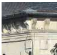
Corniche et bandeau en pierre
