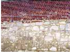
Brique et moellon calcaire
