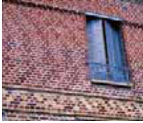
Brique rouge, brique silico-calcaire blanche
