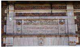
Porche en pierre ouvragée
