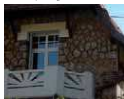
Balcon en béton d'une maison en meulière
