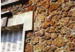
Meulière avec joint creux au mortier bâtard
