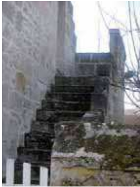
Escalier en pierre sur pignon
