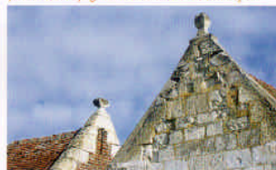
pointes de pignon avec fleurs du maçon
