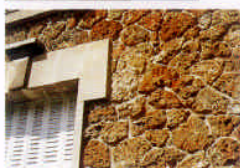
meulière avec joint creux au mortier bâtard
