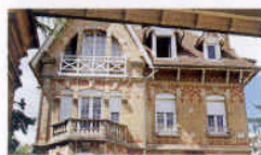
mouvements de toiture : croupes, noues, ornements sur les rives et les faîtages
