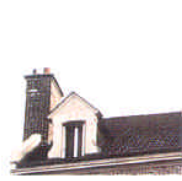
Lucarne maçonnée en bâtière.
