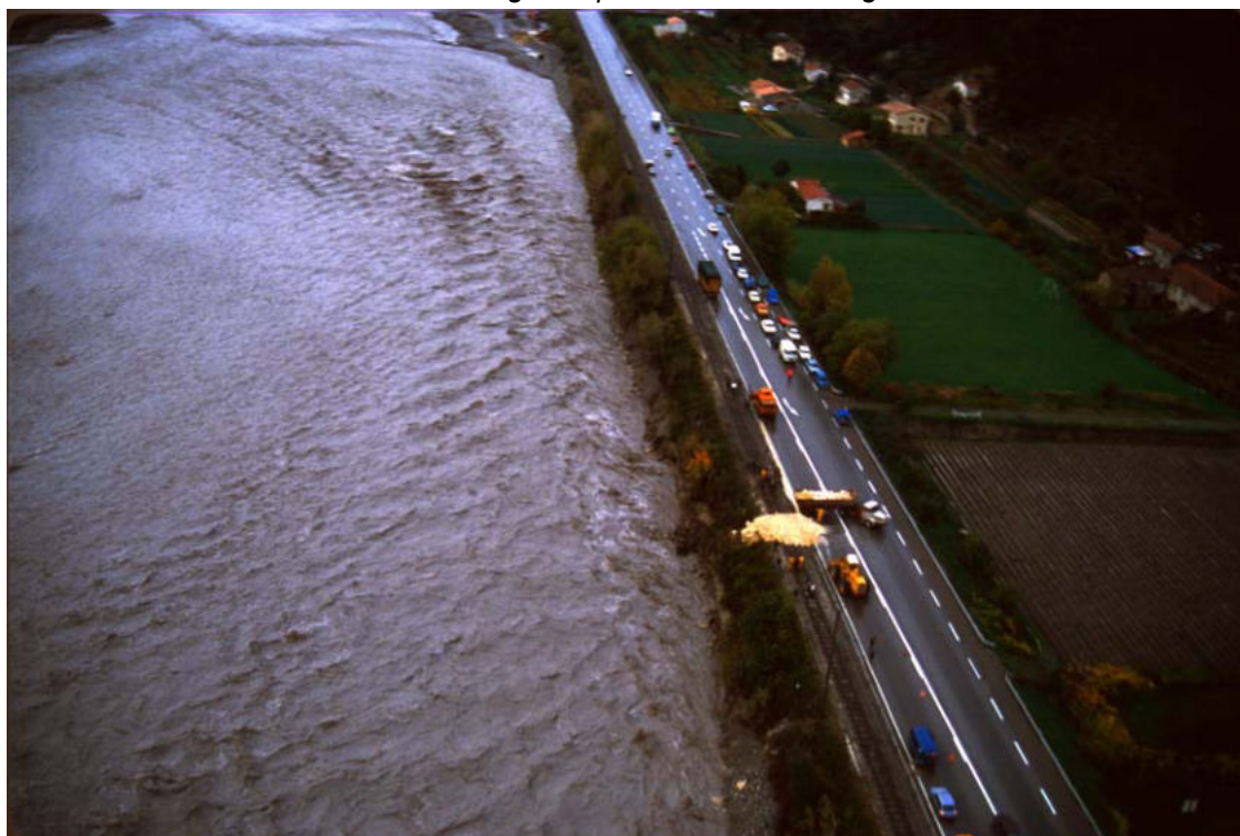
Intervention en urgence pour consolider la digue
