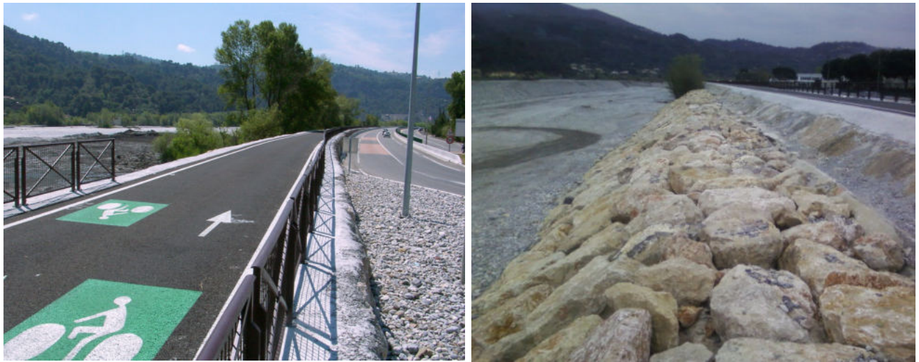
Rehausse et consolidation de la digue de Carros – Le Broc (photos : DDTM 06 – juin 2010)
