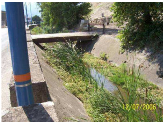
Exemple de ponceau sur le canal, ponceau sous calibré
