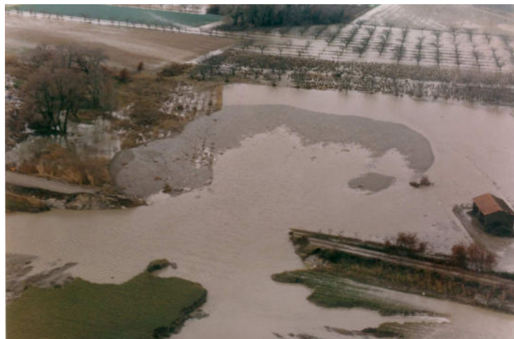
Rupture de digue sur la Durance (janvier 1994) : noter le surcreusement dans la brèche et le dépôt de sédiments à l'aval
