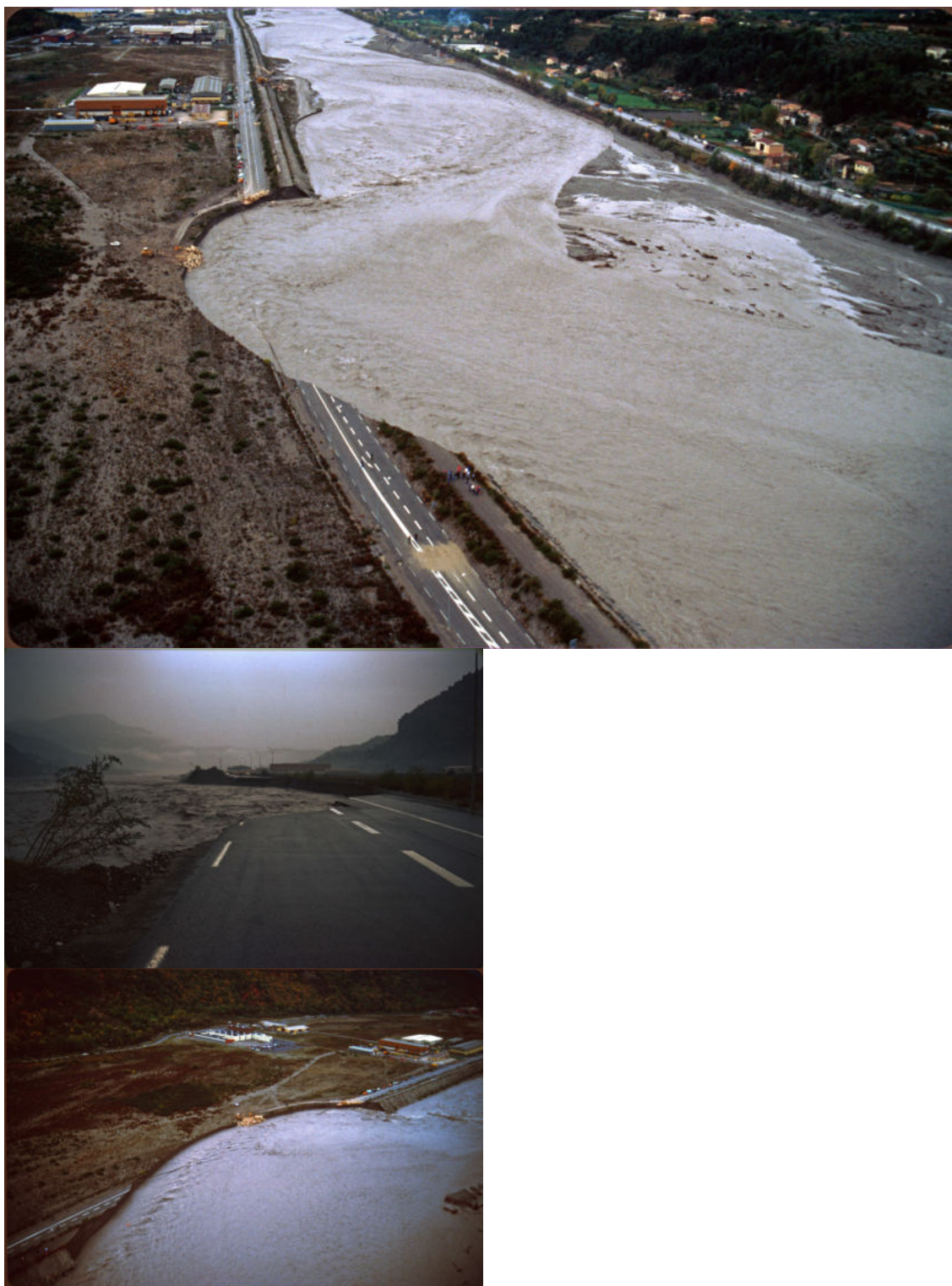
Crue de 1982 à Carros (érosion en rive droite)
