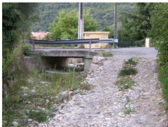
Ouvrage de pied de coteau
