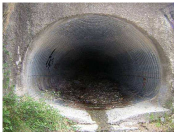
Entrée et sortie de la buse ARMCO
