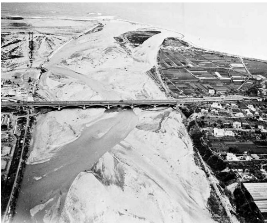
L'embouchure du Var - vue vers l'aval avec le pont Napoléon.
