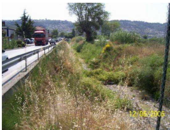
Vue vers l'aval du vallon
