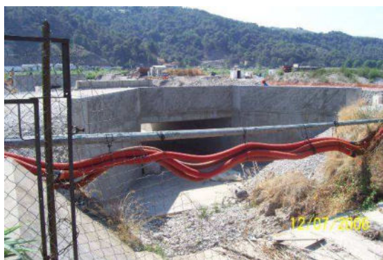
Ouvrage OH10 de la 202b
