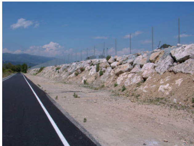
Ouvrage de protection de l'autoroute A8 rehaussé (photos :DDTM 06 – juin 2010)
