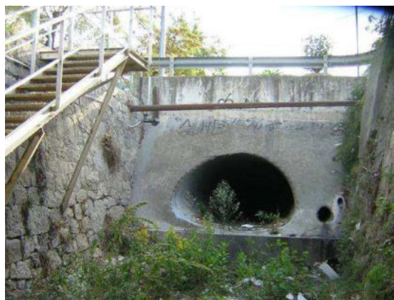
Ouvrage de sortie de l'aval de la couverture
