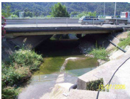
Ouvrage au Var
