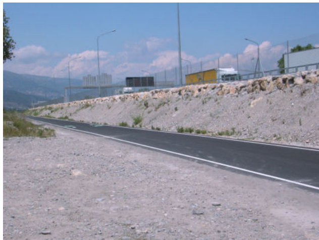
Ouvrage de protection de l'autoroute A8 rehaussé (photos :DDTM 06 – juin 2010)
