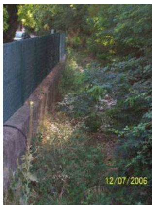
Vallon tronçon amont
