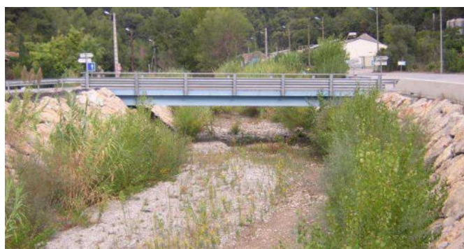
Ouvrage de franchissement provisoire
