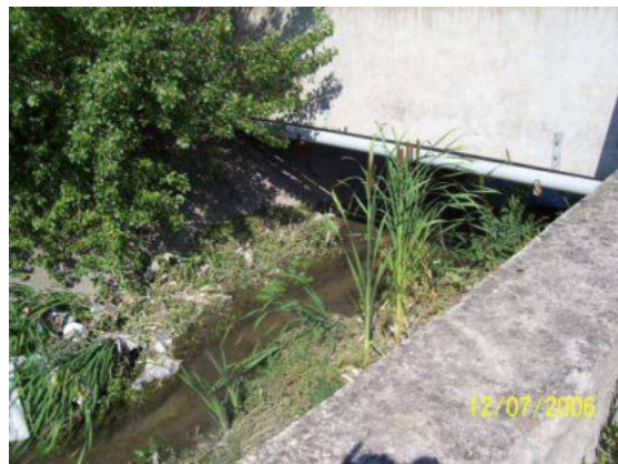
Exemple de ponceau sur le canal, ponceau sous calibré
