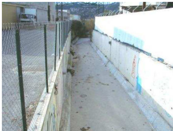
Cuvelage aval chemin de Saquier
