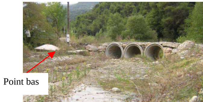
Vue amont (oct. 2004) des trois buses de franchissement du vallon
