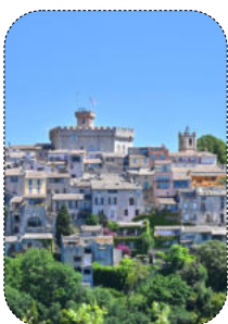
01 Les façades enduites
