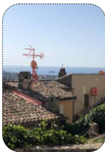
16 Intégration des éléments techniques
