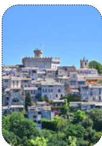
01 Les façades enduites
