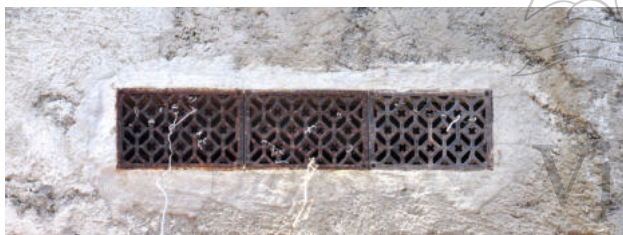
Grille de ventilation intégrées dans la maçonnerie
