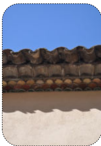
13 Les débords de toiture
