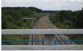
Voie TGV - Muncy-Nieurlet
