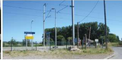
Voie TER - Nortkerque
