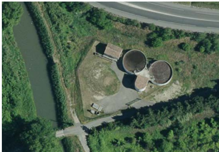
Vue aérienne de la station du bourg
