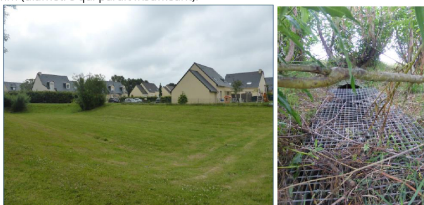
Figure 26 : Prises de vue du bassin de rétention depuis son angle nord-ouest, ouvrage d'entrée dans le bassin
