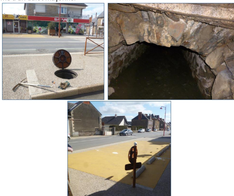
Figure 36 : Prises de vue du carrefour (depuis trottoir Est, le dalot, depuis le trottoir ouest)
