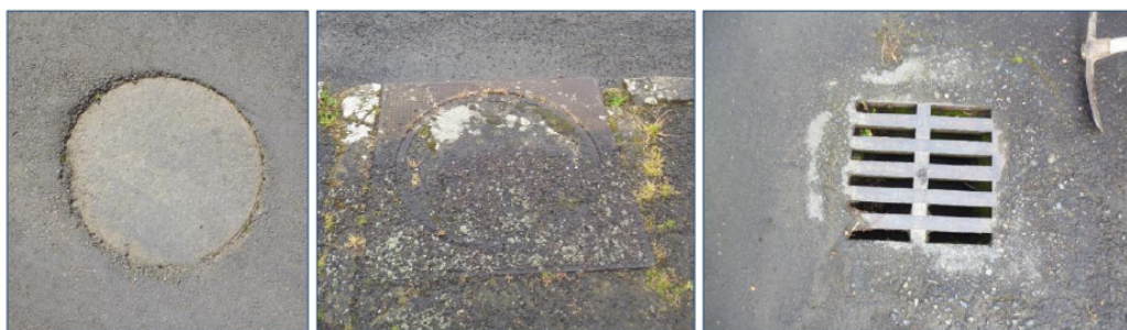
Figure 23 : Prises de vue de regards scellés par le bitume (rue du Puits Ruellan, rue Nationale, allée des Merisiers)
