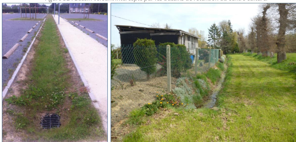
Figure 33 : Prises de vue noue est sur le parking - Fossé exutoire en bordure de parcelles privées
