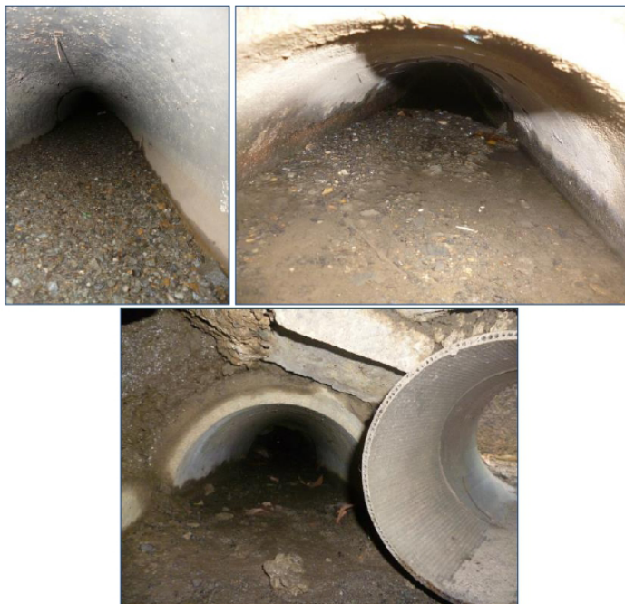
Figure 20 : Prises de vue des tronçons colmatés (rues de la Touche, du Champs des Cours, du Stade)
