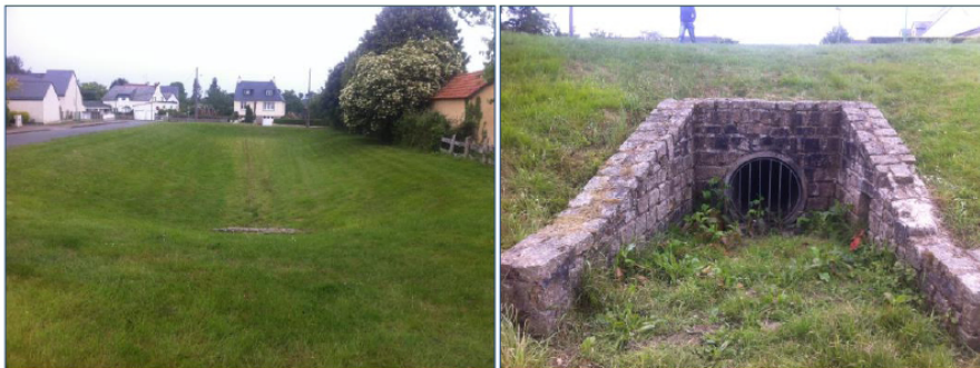
Figure 24 : Prises de vue du bassin de rétention depuis son extrémité sud, ouvrage d'entrée dans le bassin
