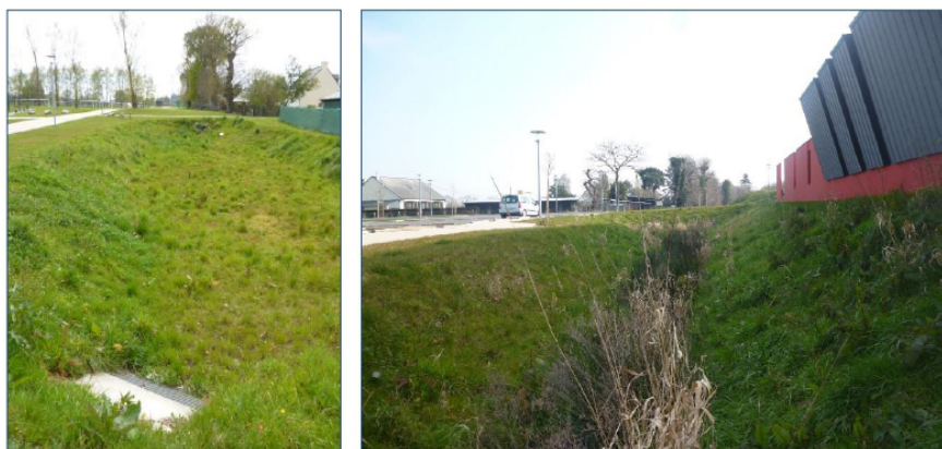
Figure 29 : Prises de vue des bassins de rétention amont et aval
