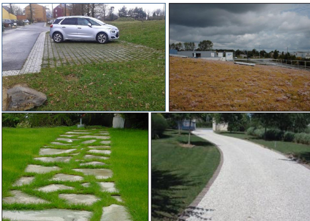
Figure 44 : Exemples de limitation de l'imperméabilisation (parking et cheminements perméables, toitures végétales)
