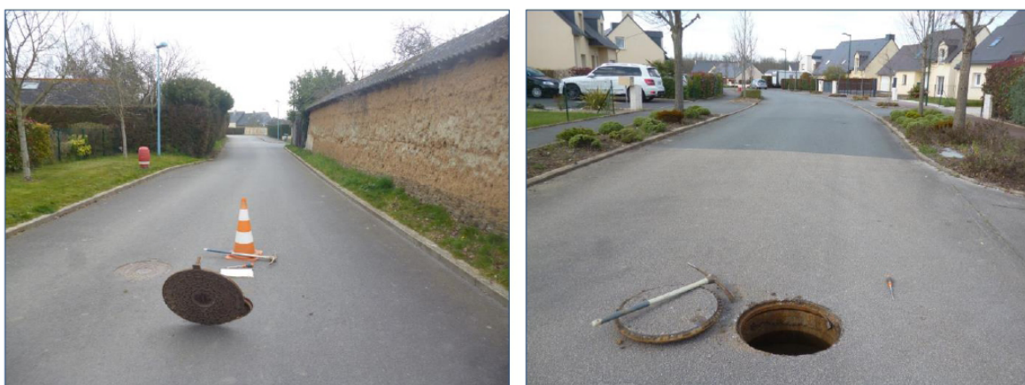
Figure 10 : Prises de vue Lotissement les Terrasses du Canal, lotissement les Jardins du Linon
