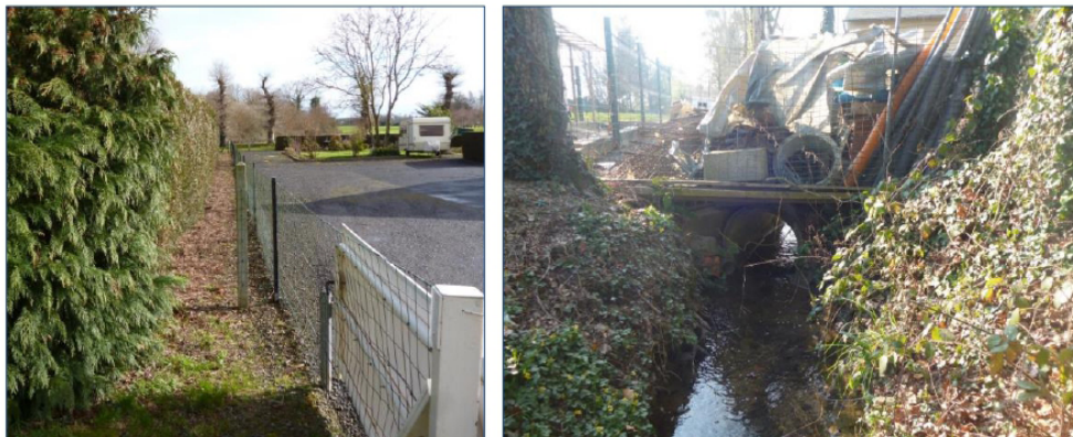
Figure 34 : Prises de vue des busages du cours d'eau est (avenue de Chateaubriand, les Cours)
