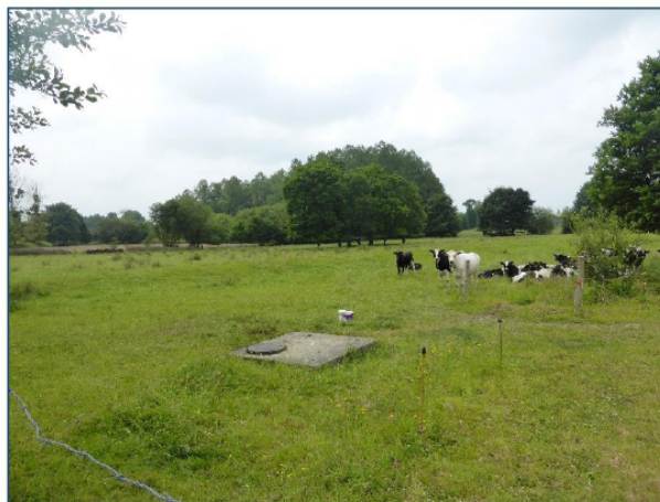
Figure 17 : Prise de vue du bassin de rétention depuis le pont sur le bras est du Romoulin
