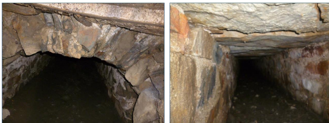
Figure 12 : Prises de vue dalot rue Nationale, rue du Vieux Moulin
