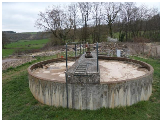
Photos 3 et 4 : Vues du bassin d'aération et du clarificateur
