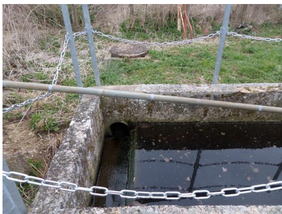
Photos 7 et 8 : Vue du canal de sortie et du regard n°71 recevant les eaux traitées
