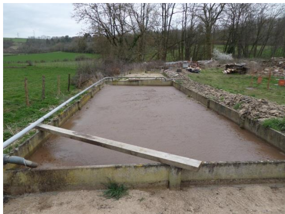
Photos 7 et 8 : Vue du canal de sortie et du regard n°71 recevant les eaux traitées
