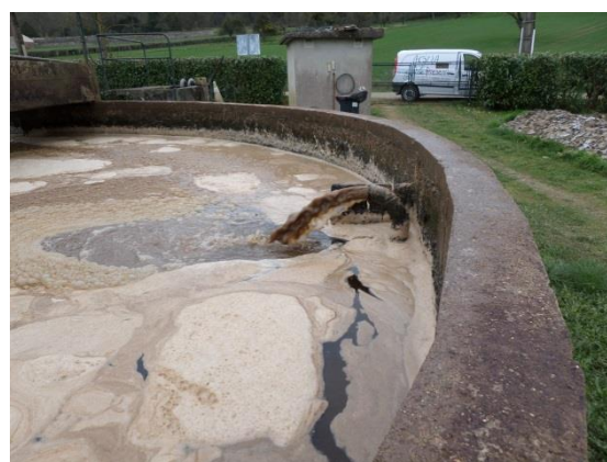
Photos 5 et 6 : Vues du regard de recirculation des boues et de la recirculation au niveau du bassin d'aération
