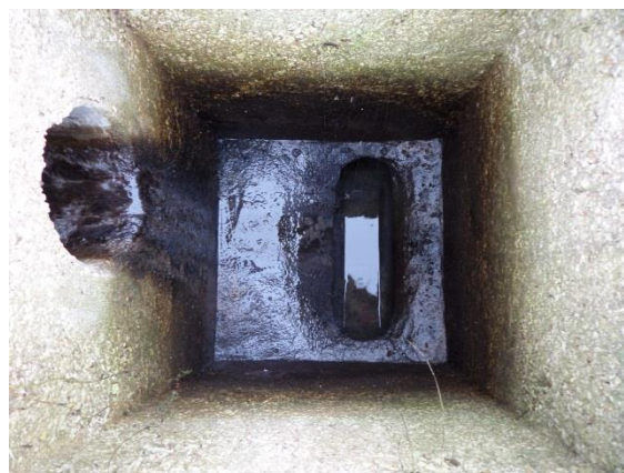
Photos 7 et 8 : Vue du canal de sortie et du regard n°71 recevant les eaux traitées
