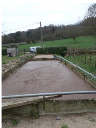
Photos 7 et 8 : Vue du canal de sortie et du regard n°71 recevant les eaux traitées
