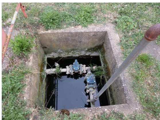
Photos 5 et 6 : Vues du regard de recirculation des boues et de la recirculation au niveau du bassin d'aération
