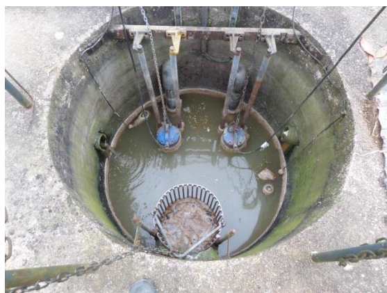
Photos 1 et 2 : Vue du poste de relevage et du dessableur
