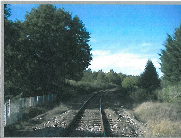
Photo 19 : Voie ferrée non clôturée d'Objat
