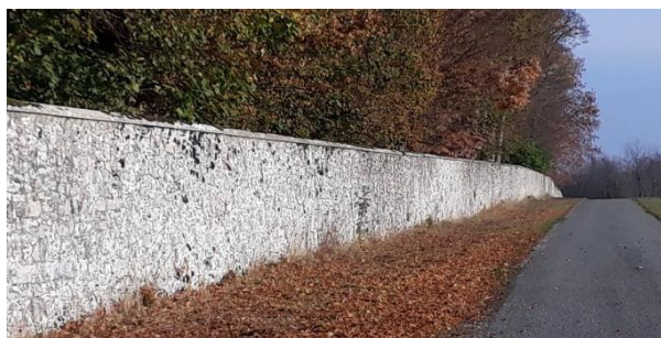
Mur d'enceinte du Château de la Trousse
