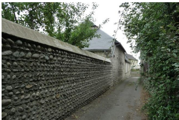
Mur de clôture en galets
