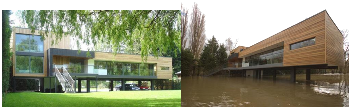
Figure 13 : Exemple d'adaptation de l'habitat au risque inondation dans un axe de ruissellement en Angleterre
