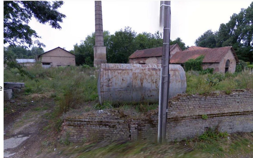
Friche industrielle - Rue des Clabaudois à Plachy Buyon
