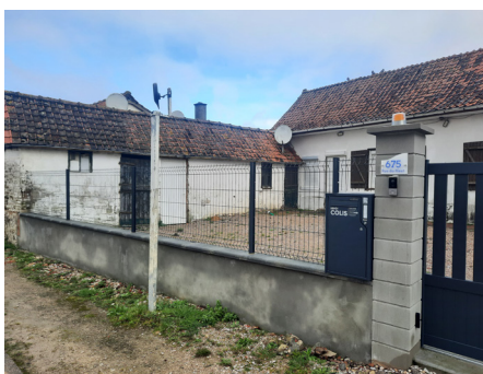
Éviter les grillages car ils appauvrissent le patrimoine. Éviter les enduits cimentés et privilégier des enduits à la chaux et sable.
