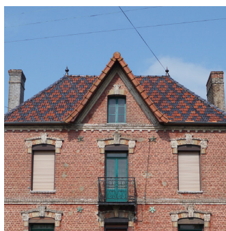
Toiture en pavillon couverte de tuiles vernissées, dont le mélange de couleurs forme des losanges.
