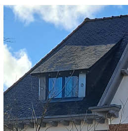
Lucarne rampante en ardoise et zinc.
