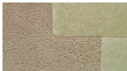
Enduit neuf lissé, réalisé au « nu » exact des pierres d'encadrement.
