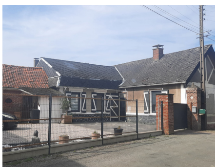
Extensions successives qui ne respectent pas la volumétrie initiale de la maison. Les toitures doivent être harmonisées.
