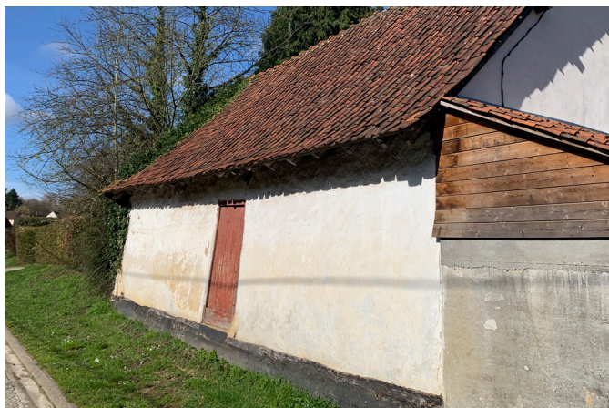
Grange en front de rue avec coyau non fermé permettant de protéger le torchis de la pluie.
