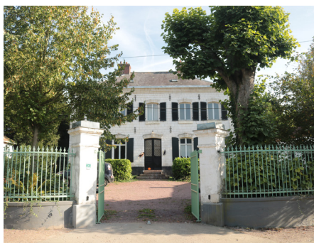
Muret enduit et pilastres en craie reprenant la matérialité de la maison. Portail et clôture en ferronnerie, complété par la végétation.
