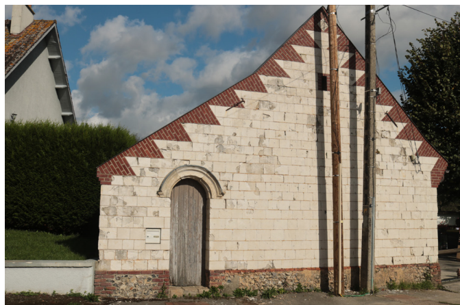
Pignon restauré en craie et épis de brique.
