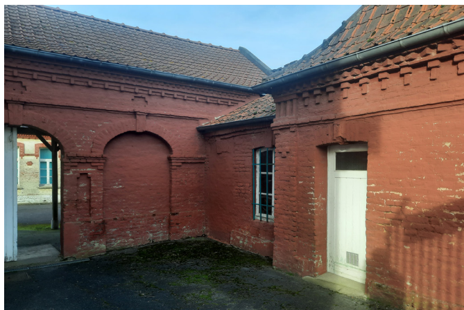
Maison et dépendances enduites à la chamotte, les briques des murs demeurent visibles, tout comme les modénatures.
