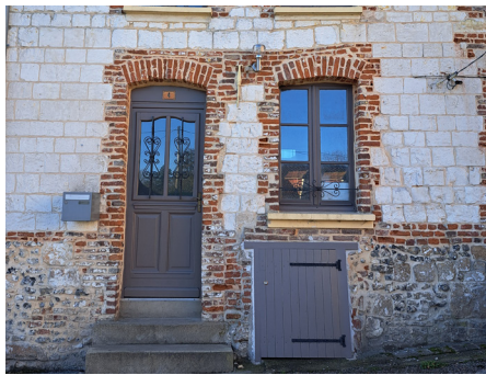
Soubassement en grès et de moellons de silex, cependant les matériaux ne sont pas appareillés.
