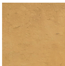
Enduit à la chaux et au sable
