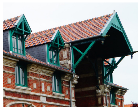
Avant-toit et lucarnes.
