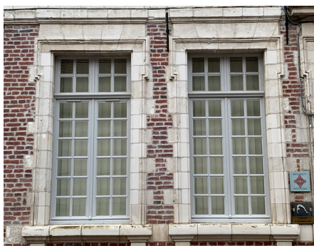
Imposte à petits carreaux.
