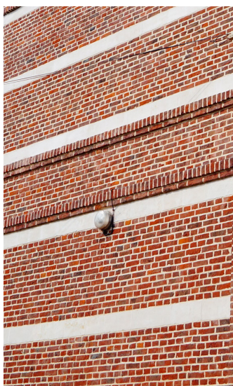
Mur en briques rouges, assemblage à la Française, cordons en brique, rangées de craie à intervalle régulier.
