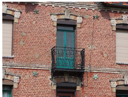
Balconnet avec garde-corps en fer forgé.
