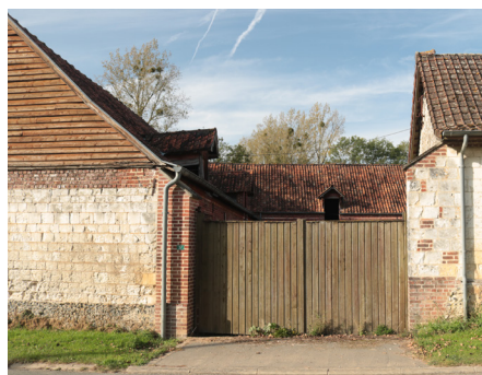
Ferme : bardage, clôture, lucarnes.
