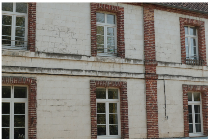
Salle communale dont les deux bandeaux accentuent l'horizontalité de la construction, et séparent les deux niveaux.
