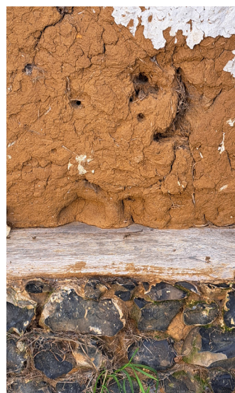
Soubassement en moellons de silex, sablière basse en bois, torchis et restes d'enduit chaulé.
