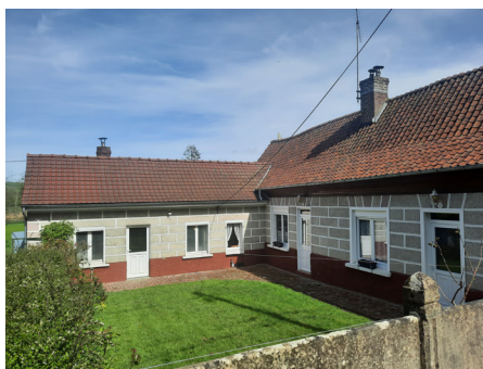
Façades en fausses pierres gravillonnées.
