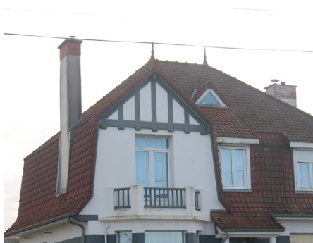
Villa d'inspiration balnéaire dont l'épaisseur de l'enduit cimenté fait apparaître de faux pans de bois en façade et sur le pignon.
