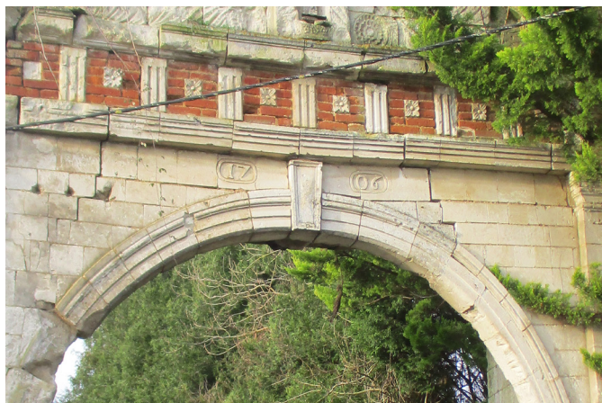
Porche d'entrée d'une ferme, en craie et brique. Ouverture plein cintre avec clé sculptée.
