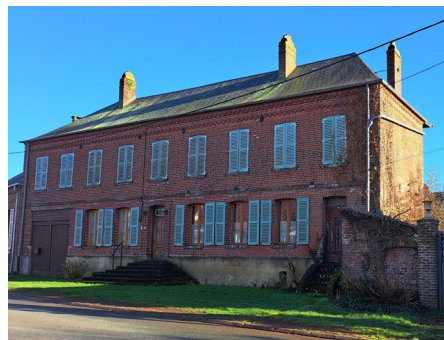
Maison et dépendances enduites à la chamotte, les briques des murs demeurent visibles, tout comme les modénatures.
