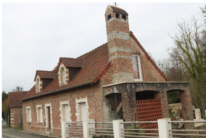
Longère à la restauration récente, cheminée réalisée en brique et en grès.
