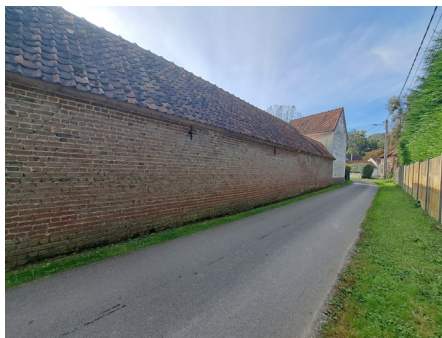
Long mur en brique, appareillage à la Française : alternance d'assises de boutisses et de panneresses.
