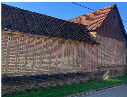
Pans de bois hourdés de briques.
