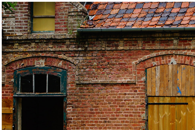
Cordon en brique qui prend la courbure des linteaux cintrés. Il permet de souligner l'architecture de ces écuries.
