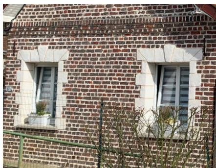
Les encadrements en pierre de parement doivent être le plus fidèle possible aux vrais pour éviter l'effet "pastiche".
