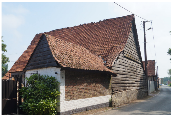
Ferme dont les pignons des dépendances sont couverts d'un bardage en bois posé à clin.
