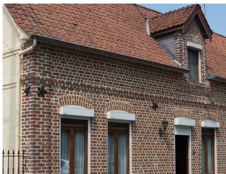
Cordon en brique sur mur en brique, ce qui permet de donner du relief à la façade, tout en marquant le niveau supérieur.
