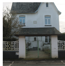
Porche d'entrée avec toiture en ardoise.
