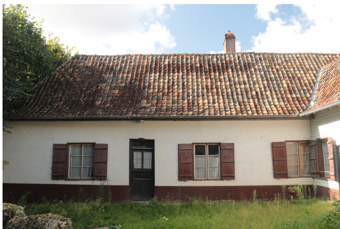
Longère traditionnelle en torchis, fenêtres à 6 carreaux et deux battants, volets en bois.
