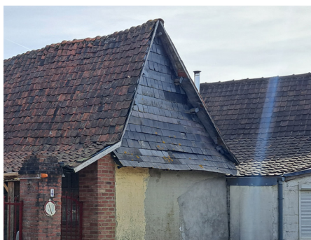
Sur les pignons en ardoise.
