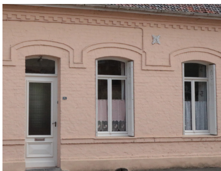
Cordon en brique qui souligne les ouvertures.
