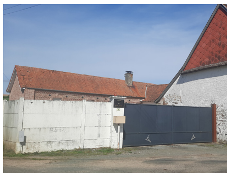
Éviter les murs pleins et hauts, de même pour les portails. Privilégier le végétal pour protéger des regards.
