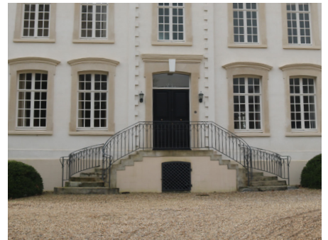
Perron à deux volées d'une maison bourgeoise.
