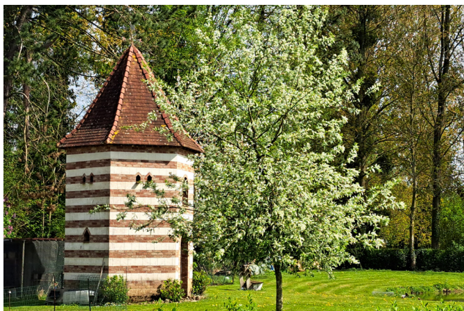
Colombier bâti récemment, avec un appareillage en rouge-barre.
