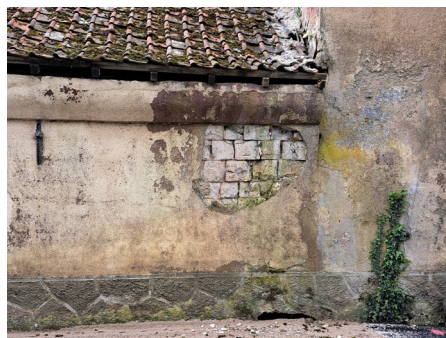
Mur en craie enduit de ciment.
