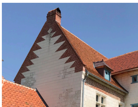
Pignon en pierre et épis de brique, restauré dans les règles de l'art.
