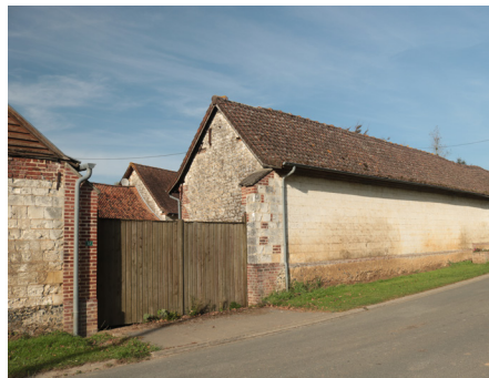
Dépendance de ferme en craie, soubassement silex.
