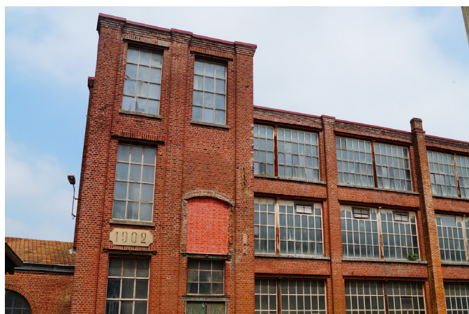
Toits terrasses sur les ateliers de la filature d'Auchy-lès-Hesdin.
