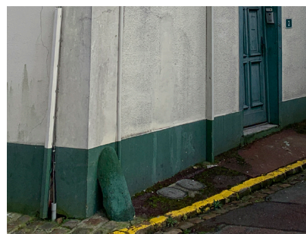
À l'angle d'une rue.
