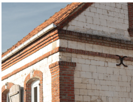
Cordon en brique sur mur en craie, le contraste entre les matériaux permet de mettre en avant les modénatures.
