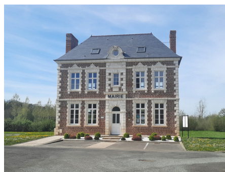
Mairie dont la couverture fut restaurée, création de châssis qui s'intègrent bien dans la toiture et qui respectent l'ordonnement de façade.
