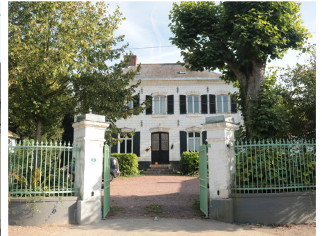
Toiture pavillon en ardoise sur une maison bourgeoise.
