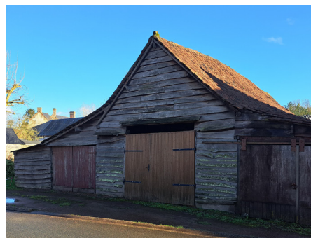
Grange en front de rue recouverte d'un bardage en bois.
