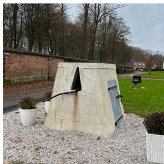
Puits à manivelle maçonné.
