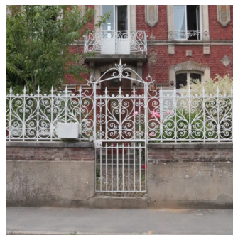
Grille de clôture et portail piéton.
