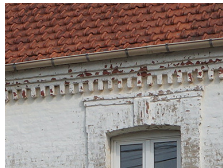
Frise en denticules, encadrement d'ouverture, clé de linteau.
