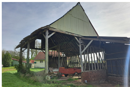
Chartil dont la structure bois a été conservée. Cependant, éviter de remplacer le bardage bois par de la tôle.
