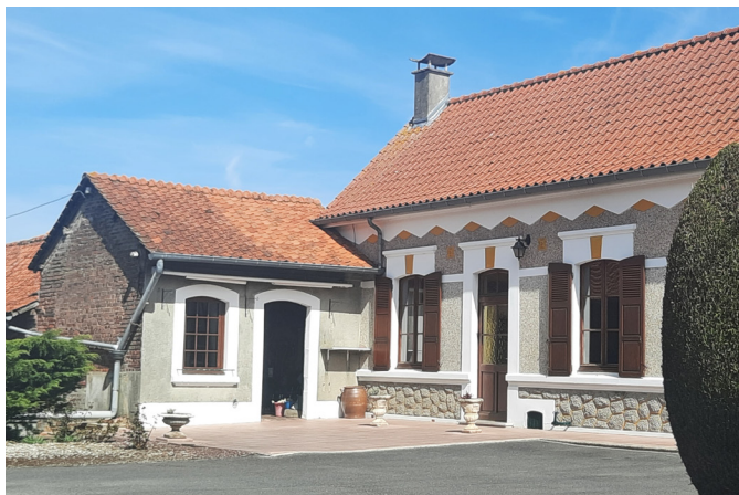
Maison en brique dont la façade est composée de deux enduits, l'un gravillonné, l'autre cimenté, permettant la création de décors.
