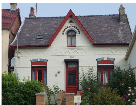
Linteaux en briques vernissées bleues, contraste avec la peinture blanche de la façade.
