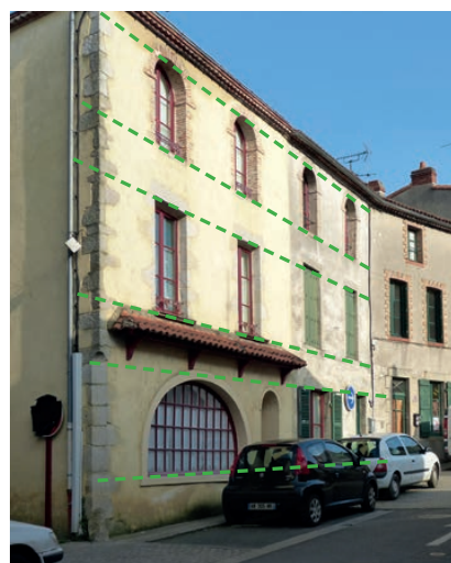
Ici la régularité des ouvertures, où allèges et linteaux sont alignés, crée des lignes horizontales composant les façades des rues.
