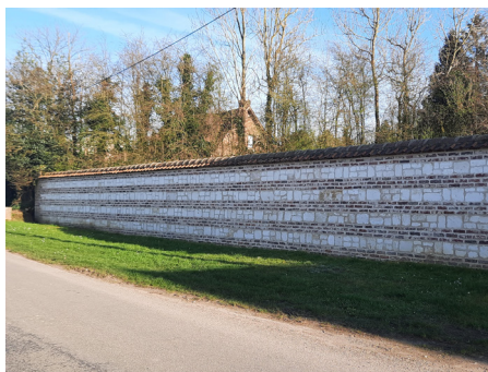
Mur en rouge-barre restauré.
