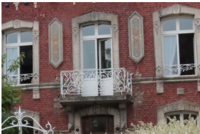
Villa avec balcon sur la travée centrale, au-dessus de la porte principale. Il est soutenu par deux consoles, et le garde-corps est en fer forgé.
