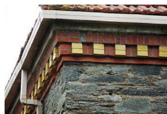
Corniche en briques naturelles et vernissées.
