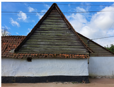
Soubassement silex enduit au coaltar, badigeon à la chaux sur torchis, auvent en tuiles, bardage bois posé à clin.
