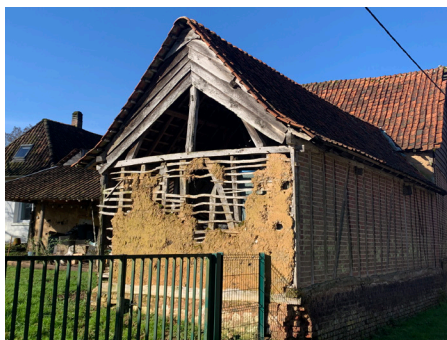
Pans de bois et torchis en décrépidité, l'entretien est nécessaire pour préserver ce patrimoine.
