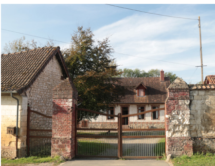
Pilastres et mur en craie et brique. Portail et portillon en bois qui laissent passer le regard.
