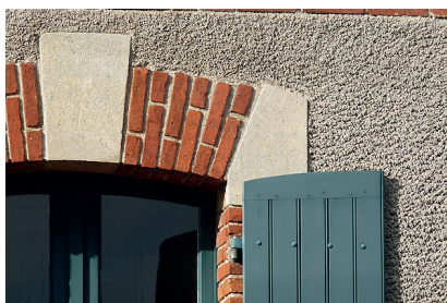
Enduit « tyrolien » ancien.
