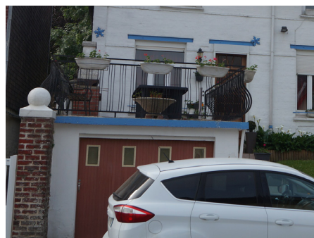
Garage dont la toiture sert de terrasse pour la maison.
