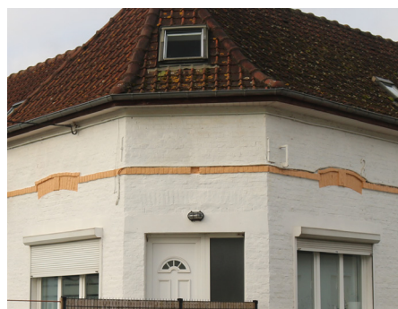
Cordon en brique peint incluant les linteaux d'anciennes baies, contraste avec le blanc de la façade.
