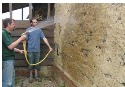
Préparation de l'accroche de l'enduit
