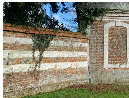
Mur de clôture d'un château.
