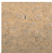
Moellons beurrés à l'argile
