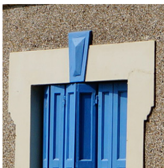
Encadrement d'ouverture en enduit cimenté, clé de la même couleur que les volets.
