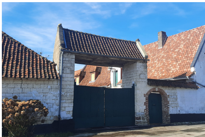
Porche monumental en craie avec couverture en tuile en bâtière, porte piétonne, dit "porget", avec encadrement en brique en plein-cintre.
