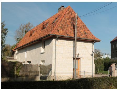
Maison en torchis à étage restaurée. Pignon en craie.
