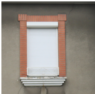
Encadrement en briques de parement.
