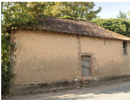
Mur en moellons de silex "beurré" à l'argile, aussi nommé mortier d'hirondelle.
