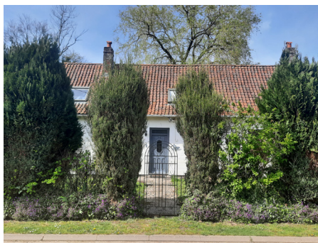
Haie composée d'essences végétales variées, portillon en ferronnerie.
