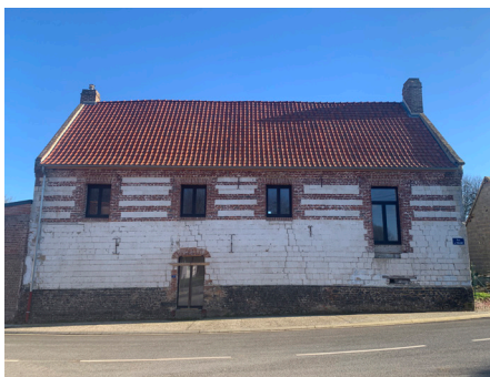
Ancien relais de poste, maçonnerie en pierre de taille (craie), sur soubassement en moellons de silex. Encadrement d'ouvertures, wamborgues, souches de cheminées en brique.
