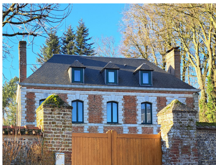
Toiture en pavillon et lucarnes en ardoise. Maison bourgeoise restaurée dans les règles de l'art.
