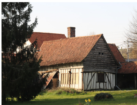
Grange restaurée, ossature en bois laissée apparente.
