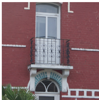
Garde-corps d'un balcon.
