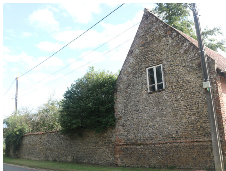
Mur de clôture et pignon maçonnés en moellons de silex.
