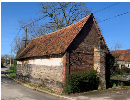
Dépendance en front de rue avec mur en torchis protégé par un bardage en bois. Permet également de protéger des projections liées au passage des véhicules.
