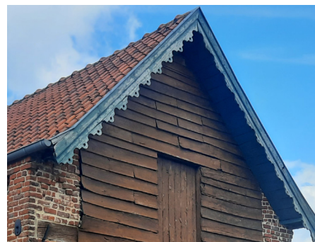
Rive de toiture, pignon.
