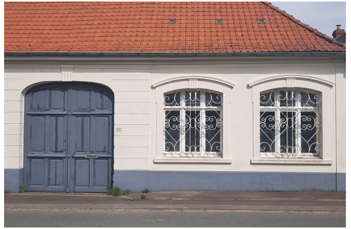
Longère en brique avec porte charretière en bois aux couleurs du soubassement.
