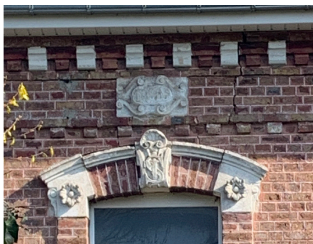
Mur maçonné en brique, décors en craie (linteau, clé de linteau, cartouche, modillons).
