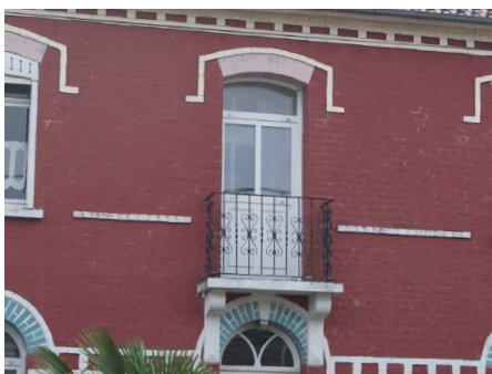
Balconnet soutenu par deux consoles avec garde-corps en fer forgé.
