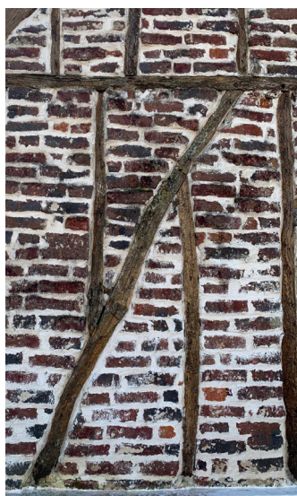
Pans de bois et appareil / hourdis de briques.
