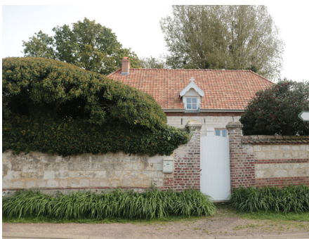
Mur haut et plein avec pilastres, en craie et brique sur un soubassement en silex, couverture en tuile.
