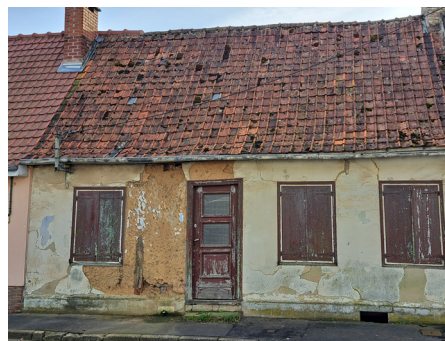
Maison en front de rue dont le badigeon nécessite d'être remis en état. La perte de celui-ci entraîne des risques liés aux intempéries pour le torchis.
