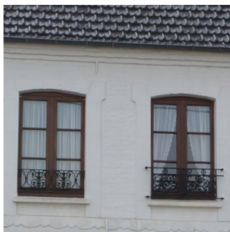
Garde-corps d'une fenêtre.
