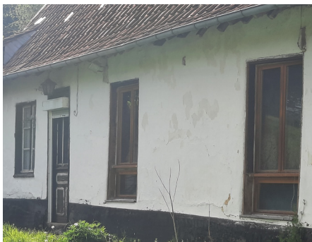
Imposte positionnée en partie basse de la fenêtre, cela rompt avec la composition traditionnelle des ouvertures, appauvrit cette longère en torchis.
