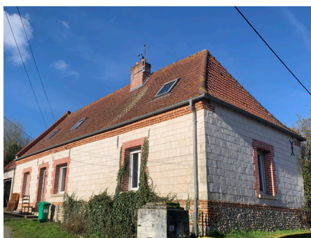
"Style Ponthieu" : soubassement silex, deux rangs de briques, pierre de taille (craie), et encadrements en brique.
