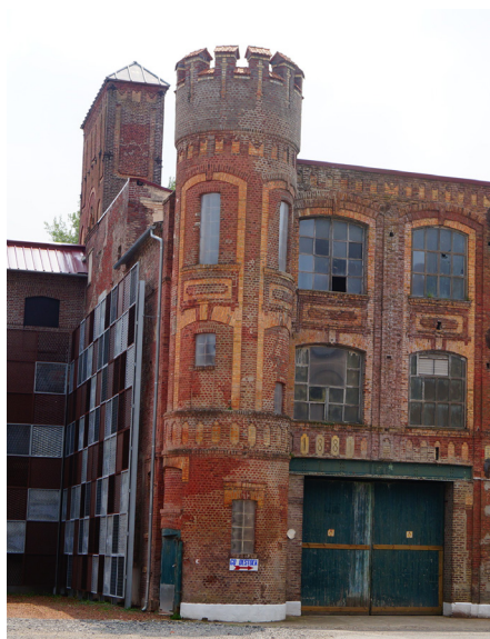
Tour d'escalier circulaire.
