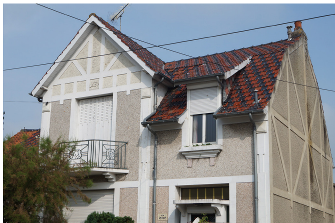
Villa d'inspiration balnéaire dont l'épaisseur de l'enduit cimenté fait apparaître de faux pans de bois en façade et sur le pignon.
