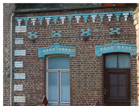
Emploi de la brique vernissée pour la frise en goutte, les linteaux, clés de linteaux, et imitation d'un chaînage d'angle harpé.
