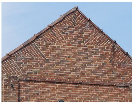
Pignon en brique avec épis de brique.
