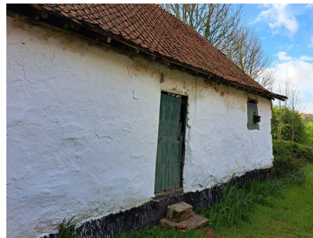
Solin en silex enduit au coaltar, mur en torchis.
