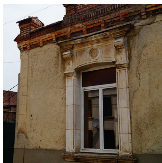
Encadrement en pierre avec frontispice à entablement.
