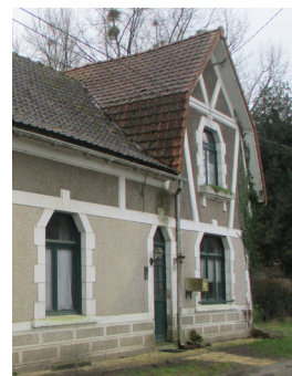
Enduit gravillonné, faux pans de bois enduits.
