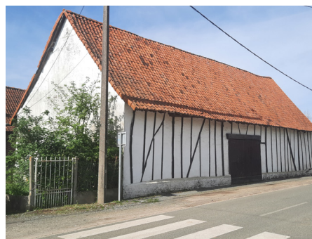
Grange restaurée, ossature en bois laissée apparente, coyau.
