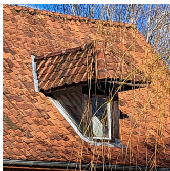
Lucarne avec toiture débordante à croupe.
