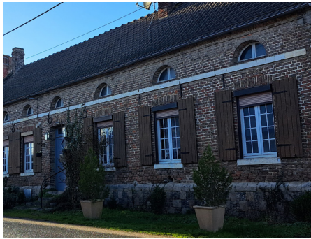
Soubassement en damier de grès et de moellons de silex.
