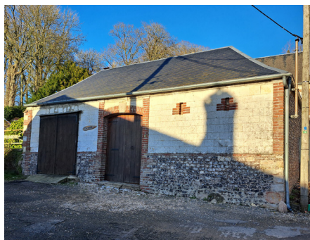
Toiture pavillon en ardoise sur une dépendance.
