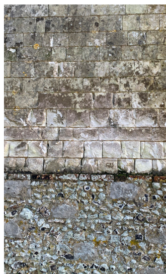
Soubassement silex et grès, rang de briques, pierre de taille.
