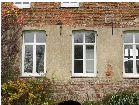
Mur en brique enduit de ciment.
