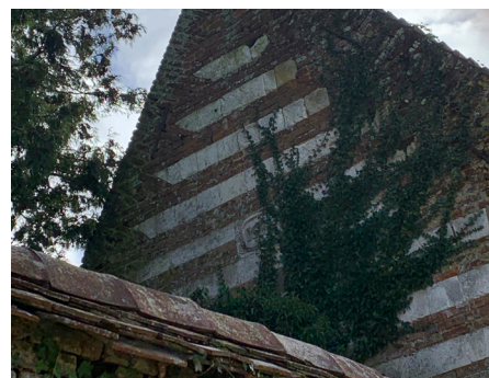
Pignon en appareillage rouge-barre et épis de briques le long des rampants de la toiture.
