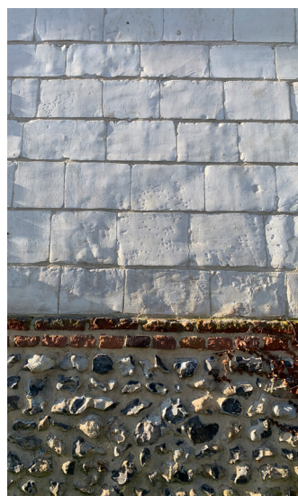
Style "Ponthieu" : soubassement en silex, deux lits de brique, pierre de taille (craie).
