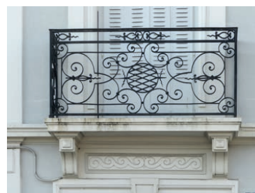
Bandeau en relief par rapport à l'enduit. Corbeaux à décor support du balcon.
