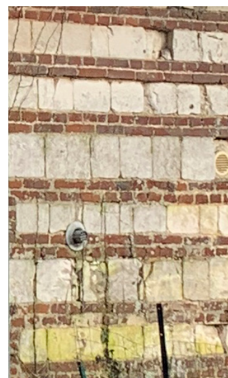
Appareillage en rouge-barre, alternance de trois lits de brique entre chaque rang de craie.
