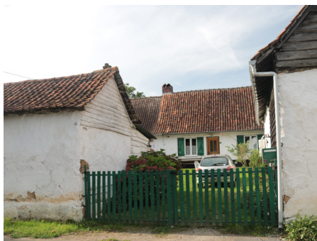
Fermette avec dépendances sur rue, en pan de bois et torchis, enduites d'un badigeon à la chaux.
