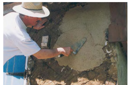
Pose de l'enduit
