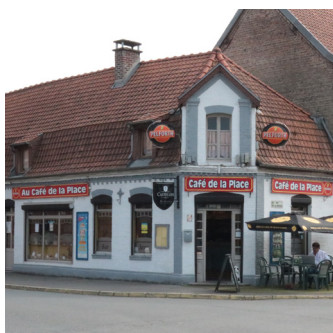
Commerce avec toiture mansardée, à angle tronqué en carrefour.
