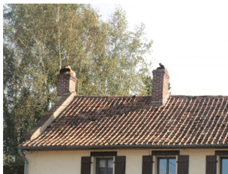
Souches en brique, implantation sur le faîtière, l'une en haut de pignon à wambergue.
