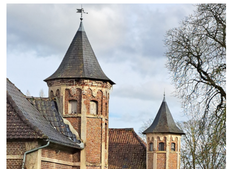
Tourelle de château avec toiture en ardoise.
