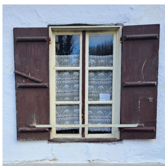
Volets en bois traditionnels à trois barres et fléau.
