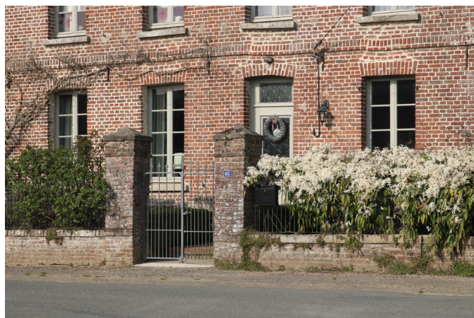
Muret en brique et pilastres, surmonté de grilles en ferronnerie. Accompagné d'une végétation composée d'essences variées, participe grandement à la qualité du bâtiment et du cadre de vie.
