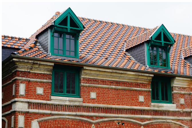
Lucarnes pendantes à toitures débordantes et lambrequins.
