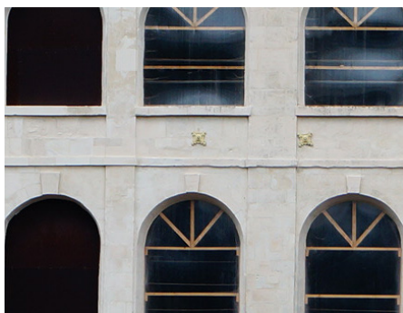
Cordon en craie, marque le passage d'un niveau à un autre.
