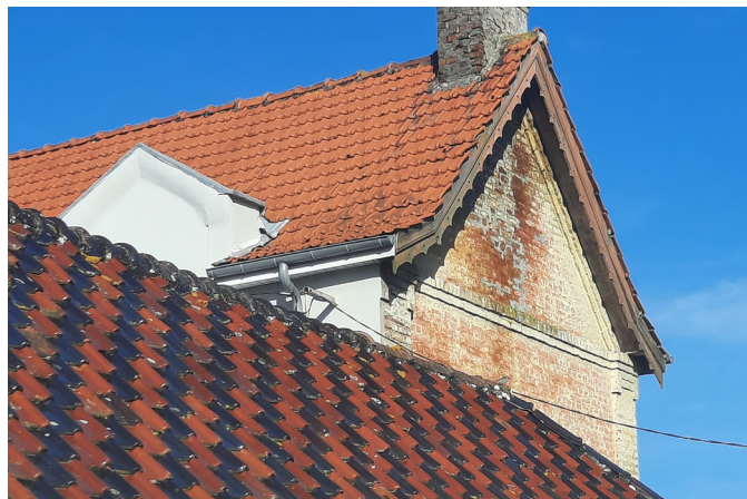
Toitures couvertes de tuiles et de tuiles vernissées.
