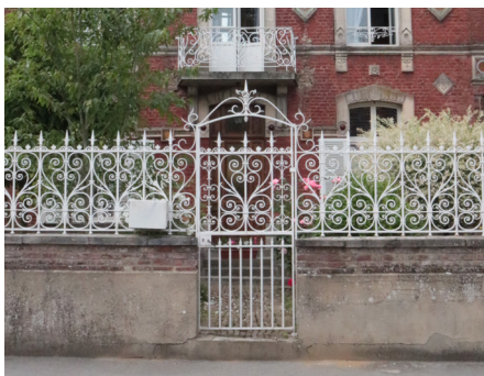
Mur en brique enduit, surmonté d'une grille en ferronnerie, portillon piéton. La peinture blanche épaissit les profils.
