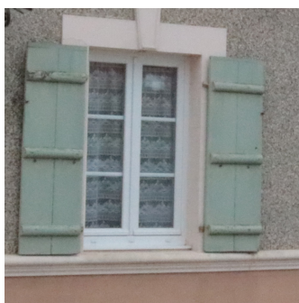
Volets en bois traditionnels à trois barres.
