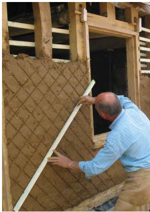
préparation à la pose de l'enduit
