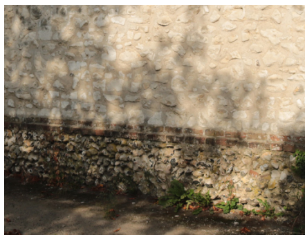
Mur de clôture en moellons de craie et de silex, séparés par deux rangs de brique. Mortier à la chaux et au sable.
