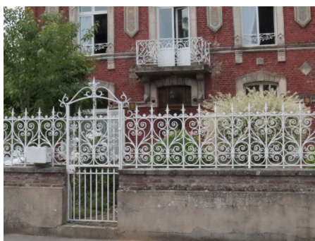
Grilles, porte piétonne, garde-corps de balcon et de fenêtres, l'ensemble des ferronneries de cette villa a été restauré. Elles participent grandement à la qualité architecturale.
