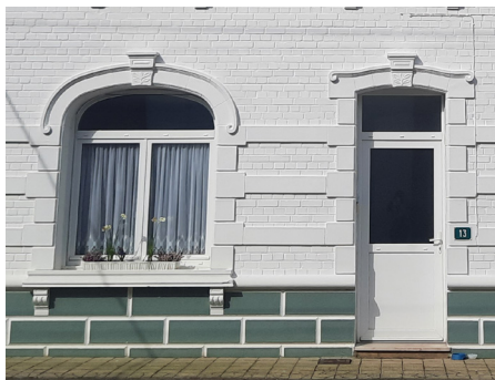
Menuiseries en PVC avec imposte qui suit la forme des ouvertures.
