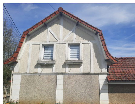
Villa d'inspiration balnéaire dont l'épaisseur de l'enduit cimenté fait apparaître de faux pans de bois en façade et sur le pignon.
