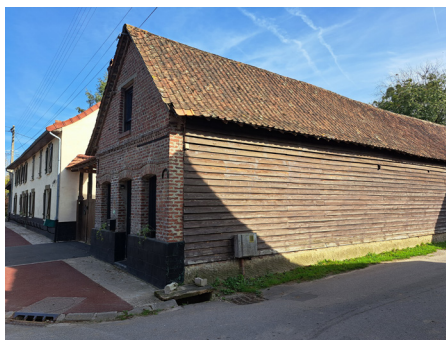
Maison dont le bardage en bois posé à clin a été restauré dans les règles de l'art, soubassement en silex visible.
