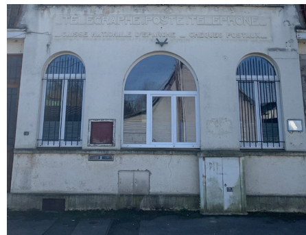
Fenêtres à impostes qui suivent la forme de l'ouverture, cependant l'imposte centrale a de trop grandes proportions, et la traverse du châssis ne s'aligne pas à des ouvertures périphériques.
