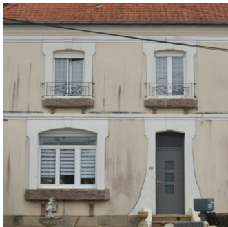
Encadrement en enduit cimenté.
