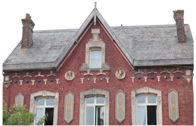
Villa avec couverture en ardoise, faîtage en zinc.
