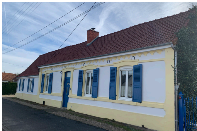
Longère à la façade cimentée, une sur-épaisseur matérialisant le soubassement, une frise en gouttes, les cordons et encadrements.
