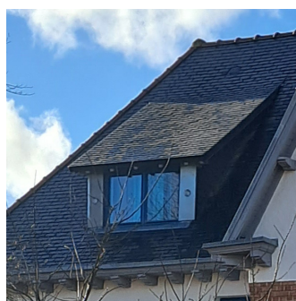
Lucarne rampante ou "chien-couché".
