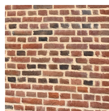
Joints à la chaux et au sable
