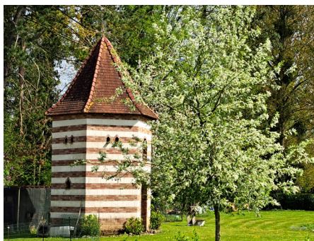
Colombier bâti récemment, respecte l'alternance traditionnelle de 3 rangs de brique entre chaque rang de craie.
