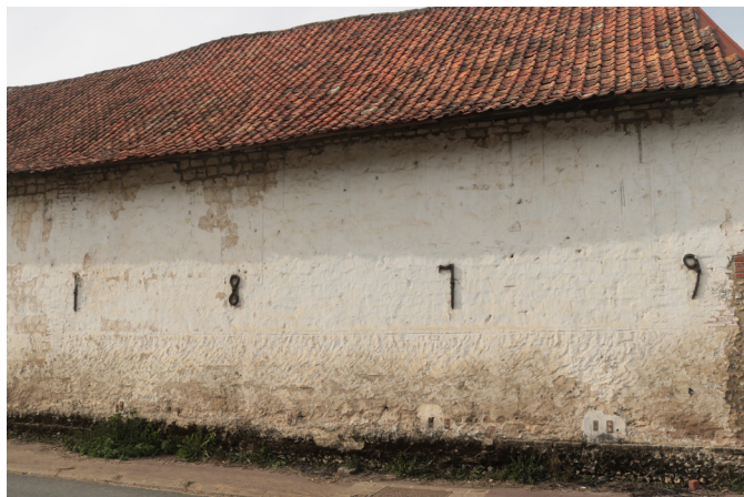
Ancres de tirants, permettent de dater la construction du bâti.
