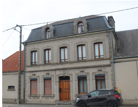
Toiture à la Mansart en ardoise sur une maison de bourg.
