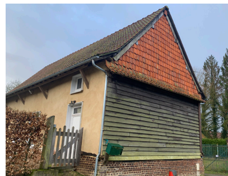
Maison en torchis restaurée.
