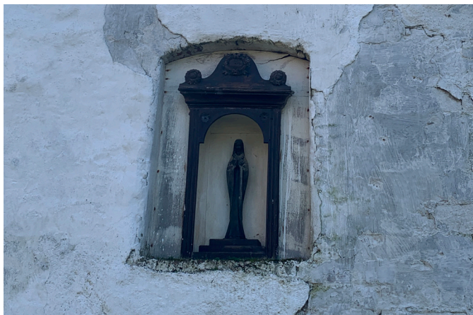
Niche dans le mur sur rue d'une des dépendances de la ferme de l'Abbaye de Fillièvres.
