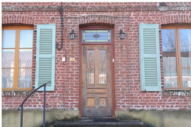
Porte en bois moulurée avec vitrage, surmontée d'une imposte vitrée. Vitraux.
