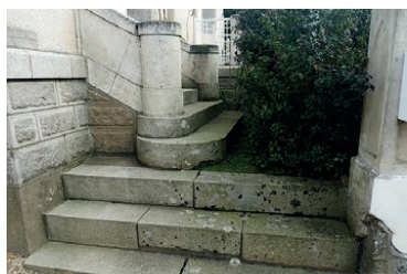
Perron d'accès, avec marches, rampes et soubassement en pierres dures.
