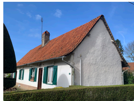
Restauration d'une longère en torchis avec badigeon à la chaux.
