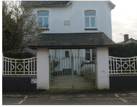
Porche d'entrée avec couverture en ardoise, grille en ferronnerie, clôture en béton ajourée.
