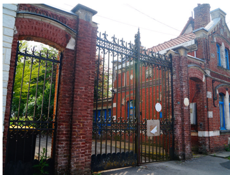
Clôture à haut portail et portes piétonnes en fer forgé, hauts pilastres en brique.
