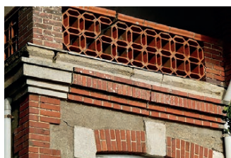
La terre cuite pour les encadrements, la corniche et le garde-corps de la terrasse.
