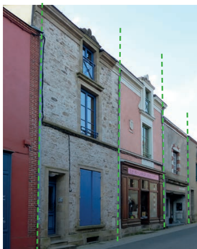
La trame urbaine de maison de ville au travers de ces lignes verticales. On remarque que la vitrine préserve la trame de la rue.
