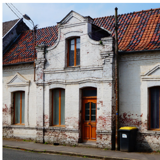
Maison implantée en front de rue avec avant-corps central de deux travées.
