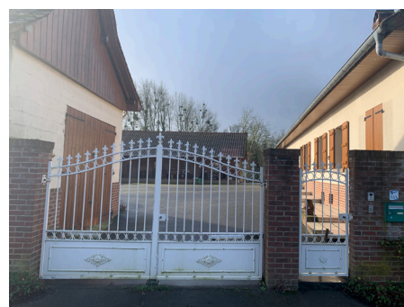
Pilastres en brique avec portail et portillon piéton en ferronnerie. Attention tout de même aux tons clairs qui épaississent visuellement les profils.
