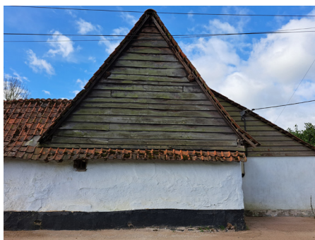
Pignon en torchis badigeonné à la chaux, bardé de bois posé à clin en partie haute, soubassement enduit au coaltar et prolongement de la toiture voisine.
