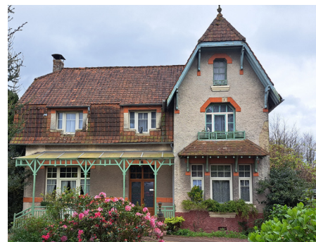
Villa d'inspiration balnéaire : consoles, lambrequins, garde-corps, auvent.
