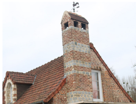
Souche en brique restaurée, en brique et grès.
