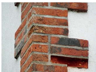
Arêtier double en brique pour une maison du bourg.
