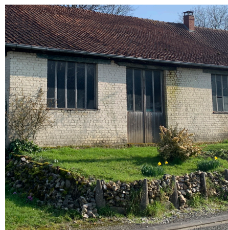
Muret de soutènement en moellons de silex.
