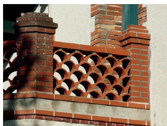
Garde-corps de terrasse à piliers de brique et claustra de tuiles.
