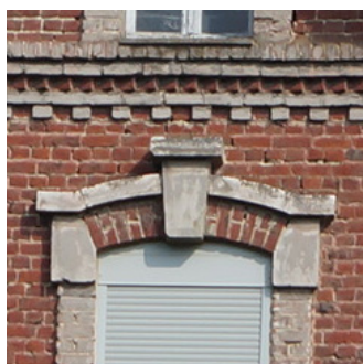
Clé de linteau en briques enduites.
