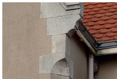
Enduit lissé réalisé au « nu » des pierres d'encadrements et d'arêtières.
