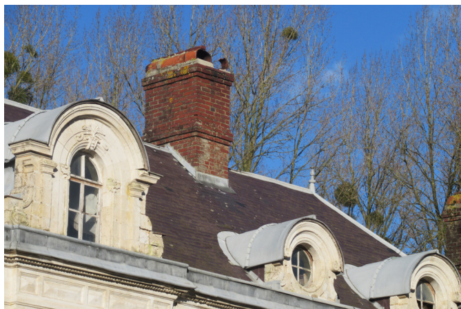
Large souche de cheminée en brique du château de Wail.
