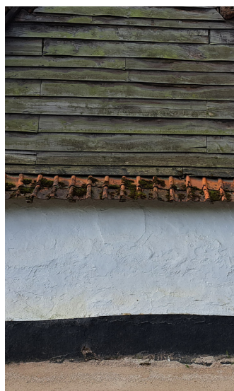
Soubassement enduit au coaltar, badigeon à la chaux, couvitrine en pannes flamandes, bardage bois.
