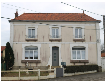
Encadrement d'ouvertures, bandeaux, pilastres corniers, soubassement en fausses pierres.
