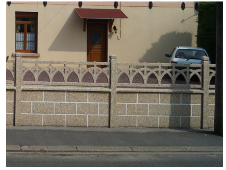
Clôture en béton, enduit gravillonné. Intègre des motifs en partie haute, perméable au regard.
