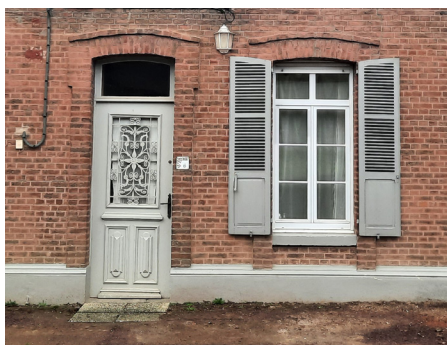
Porte et fenêtre.
