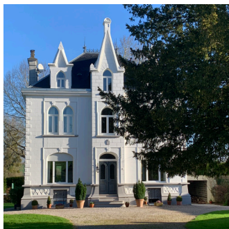
Villa avec travée centrale en avant-corps, surmontée d'une lucarne à gâbles.
