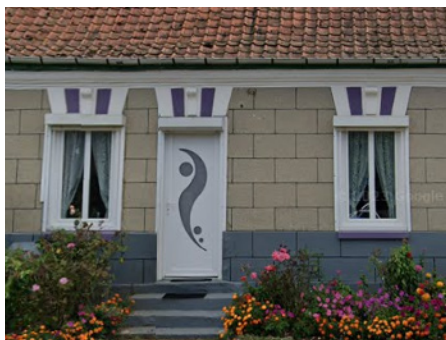
Porte standardisée qui n'apporte aucune qualité à l'intérieur de l'habitation, et appauvrit considérablement la façade.
