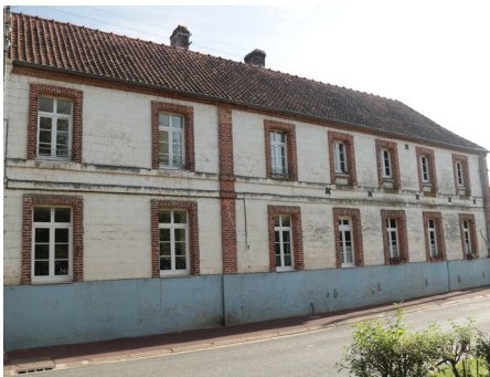
Maison de bourg en craie, encadrement et pilastres en brique.
