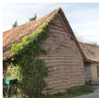
Bardage sur pignon.
