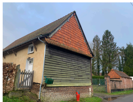
Soubassement brique, bardage bois, essentage en tuiles à débord.
