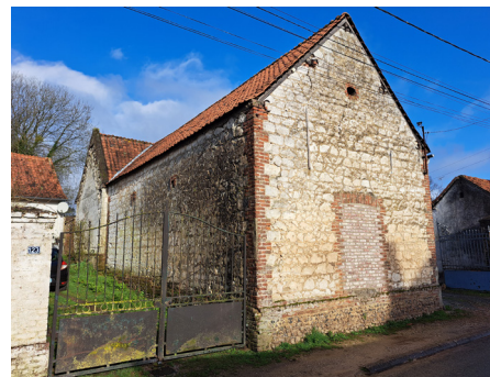
Pignon en craie, soubassement silex, chaînages d'angle harpés et encadrements en brique.
