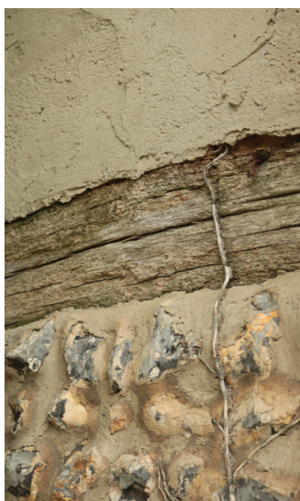
Soubassement en moellons de silex noyés dans l'argile, sablière basse apparente, enduit chaux et sable.
