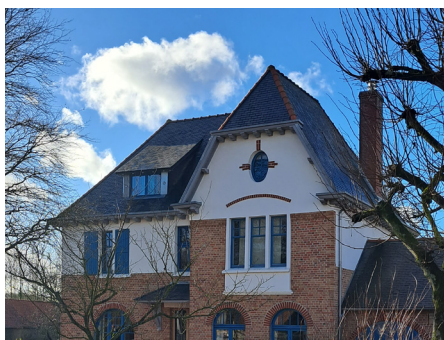
Toiture et lucarne rampante couvertes d'ardoises. Le faîtage en tuile permet un gain esthétique par le contraste des matériaux.
