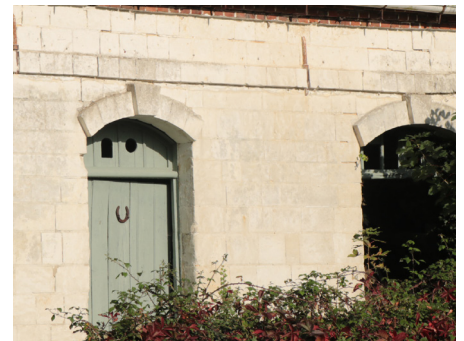
Encadrements d'ouvertures et bandeau en craie.
