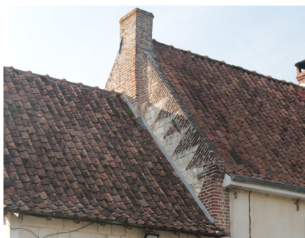
Pignon à wambergue en craie et épis de brique, surmonté d'une souche de cheminée.
