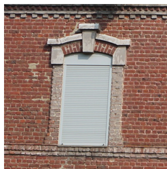
Encadrement en brique, enduit et clé de linteau.
