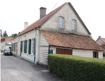
Appentis qui ne reprend pas les caractéristiques de la façade.
