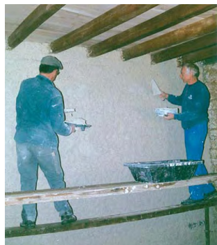
Pose d'un enduit allégé
