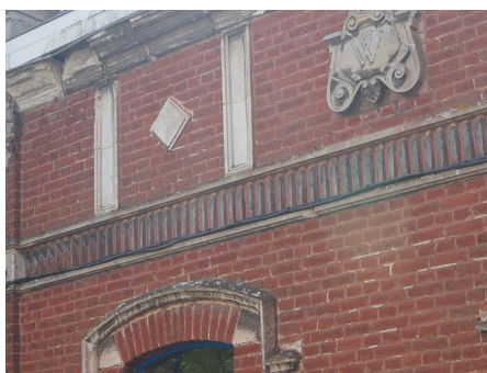
Salle communale dont les deux bandeaux accentuent l'horizontalité de la construction, et séparent les deux niveaux.
