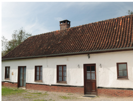
Longère à pans de bois et torchis recouverte d'un badigeon à la chaux.
