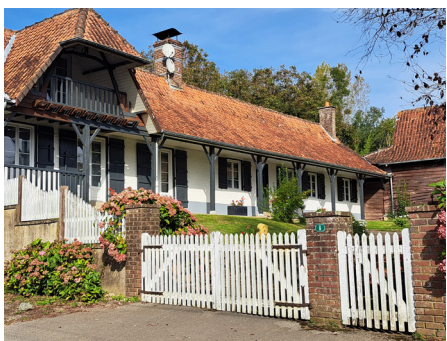
Pilastres en brique, portant une barrière en bois peint.
