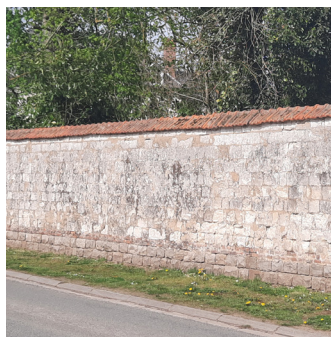
Mur de clôture en pierre couronné d'une couvertine de tuiles.
