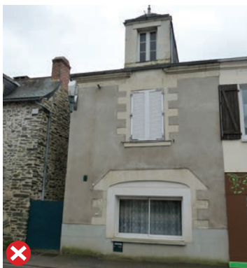
Les modénatures ont été conservées, mais le choix de la menuiserie dénature la façade. Le remplissage béton pour accueillir la nouvelle menuiserie nie l'ouverture d'origine.
