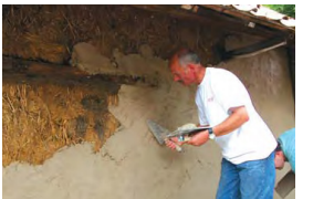
application de l'enduit
