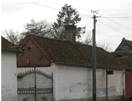
Souche de cheminée en brique d'un ancien fournil.
