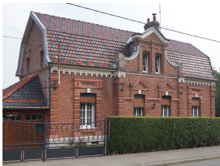
Emploi de la brique en chaînage d'angle, cordons et encadrements des baies.
