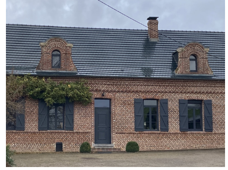
Le noir des ouvertures et des tuiles de couverture contraste avec les teintes de la brique, ensemble harmonieux.
