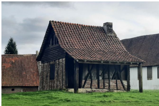
Fournil d'une ferme en ossature bois hourdée de brique. La cheminée du four dépasse de la couverture en tuile.
