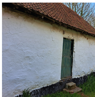
Coyau couvert de pannes flamandes, éloigne l'eau des murs.
