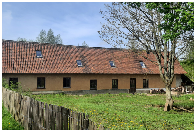
Longère en torchis restaurée. Le torchis est protégé par un enduit composé de chaux et de sable, ce qui donne cette couleur à la façade.
