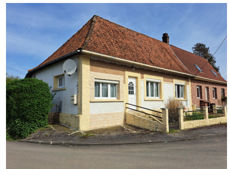
Le choix des couleurs ne s'est pas fait au regard du contexte, les teintes et l'usage de fausses pierres de parement appauvrissent considérablement ce bâti.
