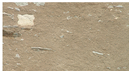
Enduit neuf « à pierres vues », possible sur des murs de clôture ou des bâtiments annexes.
