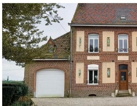
Appentis qui reprend la matérialité de la maison, ainsi que les linteaux cintrés.
