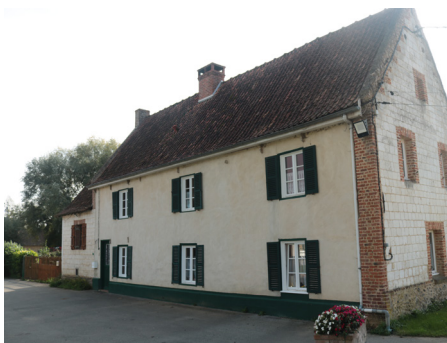
Maison en torchis à étage, restaurée.
