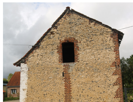
Moellons de silex, porte de grenier, brique.
