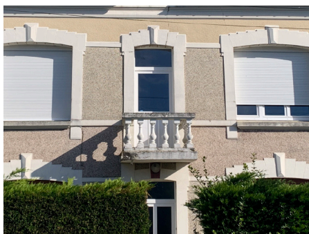
Balcon dont la protection est assurée par une balustrade.
