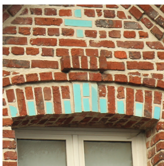
Clé de linteau en briques vernissées.
