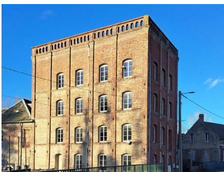
Minoterie avec toit terrasse à balustrade.
