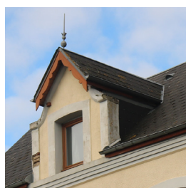
Lucarne en ardoise avec épis de zinc et lambrequins.
