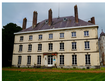
Enduit au ciment de Portland, effet pierre de taille.
