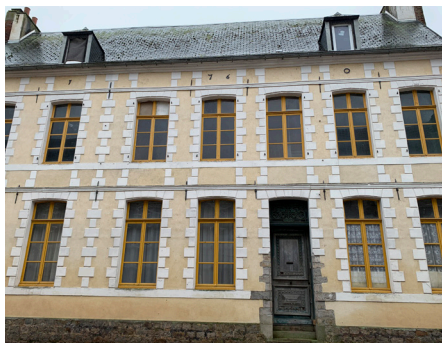
Porte et fenêtres à imposte restaurées.
