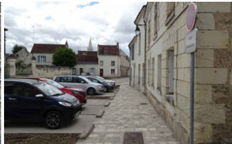
Beaulieu-les-Loches (37), Atelier de l'Ourcq : réemploi des bordures et pavés pour l'aménagement des nouveaux espaces publics du CB
