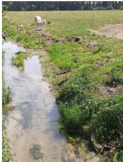
Effondrement de berge
