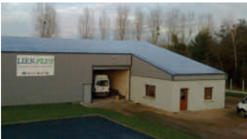
En haut : projet SAS Mine de Soleil, église à Loos-en-Gohelle Au milieu : Centrale photovoltaïque citoyenne de la SAS Capsol En bas : Centrale photovoltaïque de la SCIC Énergie Citoyenne
