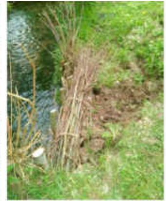
Entretien, aménagement réalisé dans le cadre des missions du SYMCEA
