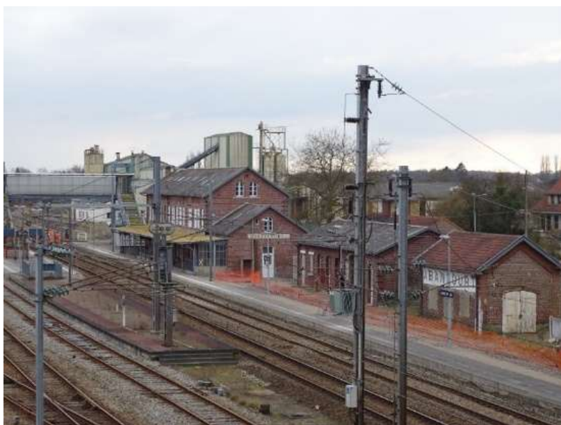
Figure 14 – Gare SNCF d'Abancourt source : Equipe PLUiH
