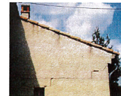
Exemple : Fissurations dues à la sécheresse
