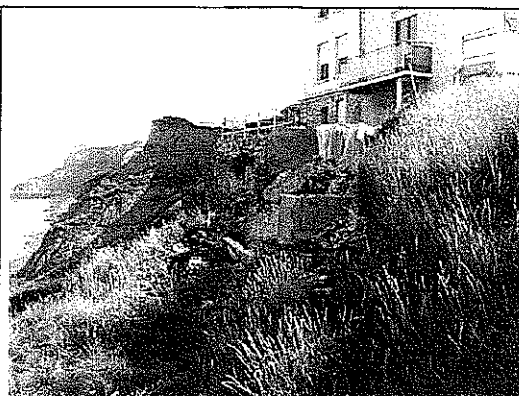
Fig 19 Wimereux Nord : désordres sur habitation
