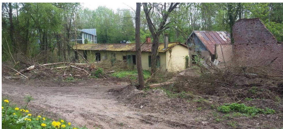
L'entrée de la friche industrielle en contre-bas de la rue du chevreuil
