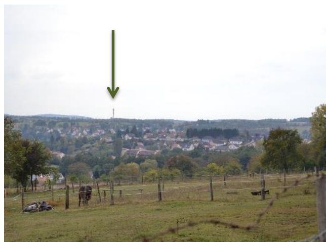
Antenne FREE MOBILE de Niederbronn-les-Bains – hauteur : 49 m
