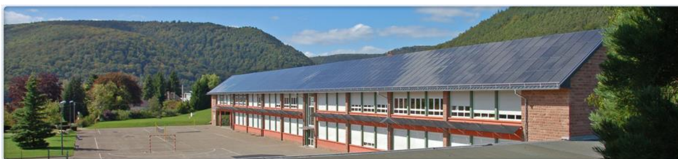
Toit photovoltaïque sur le groupe scolaire de Niederbronn-les-Bains
