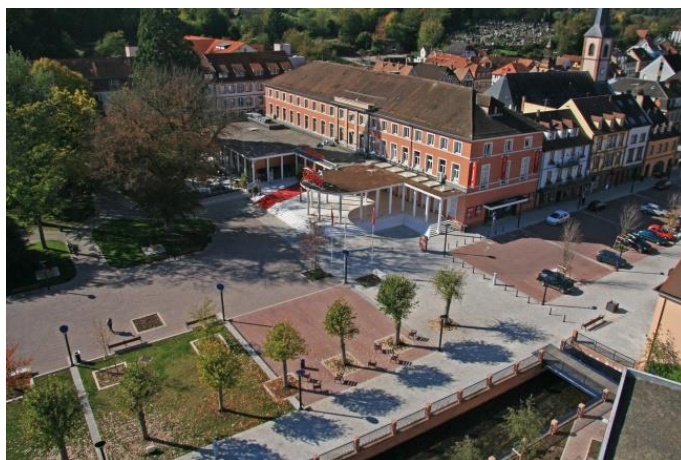
Casino de Niederbronn-les-Bains
