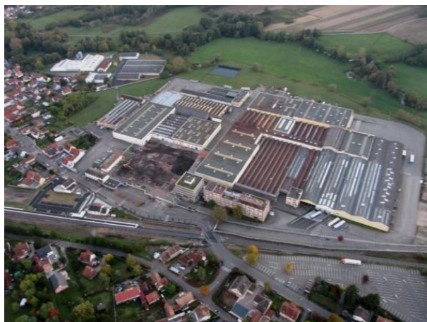
Usine De Dietrich de Mertzwiller
