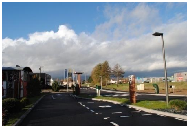
Gundershoffen – zone d'activité en entrée par la RD1062 – entrée Ouest
