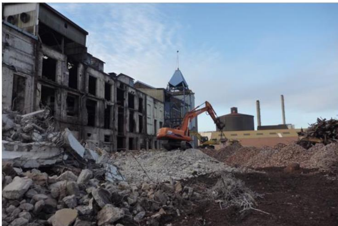
Démolition du Site STORA ©CMMO
