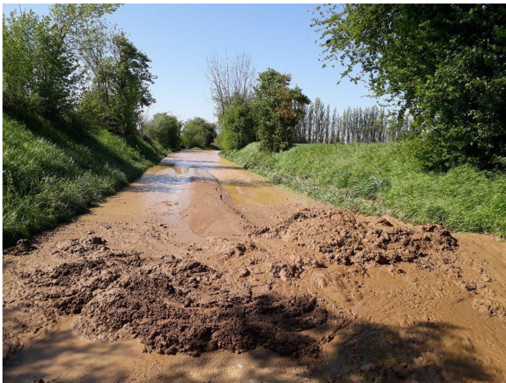
Coulées de boue survenues au printemps 2020 © CCOM
