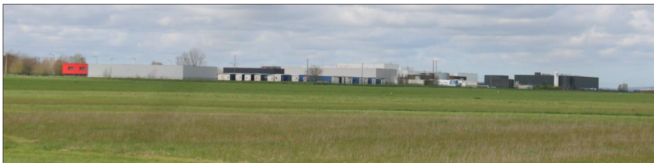
Vue sur la Zone d'Activités de l'Aérodrome depuis la RD950
