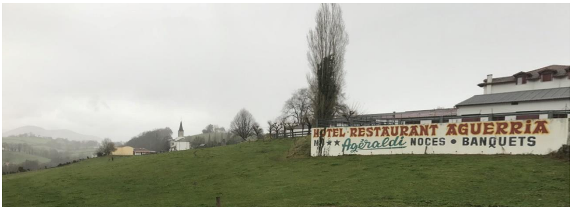
Fig. 8. Photo du site depuis le Sud
