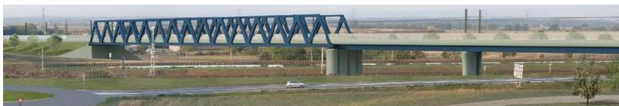
Futur viaduc de Pompignan
