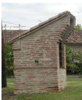
Puits à Fabas
