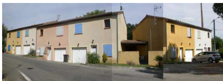
Opération de maisons en bande à VILLEBRUMIER
