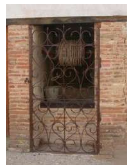
Puits à Villebrumier
