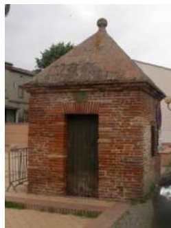
Puits à Grisolles
