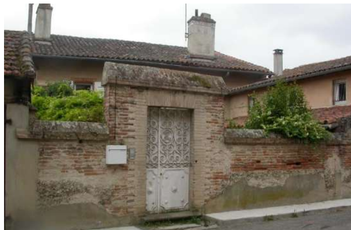
Mur et portail à l'alignement sur rue donnant accès au bâti, ancienne ferme urbaine
