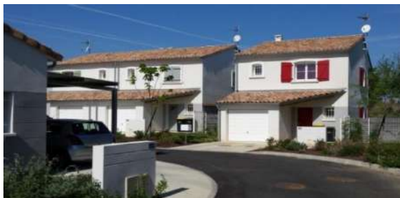
Opération de maisons en bande à GRISOLLES
