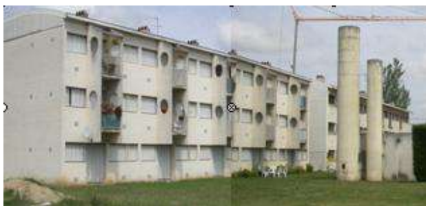
LABASTIDE-SAINT-PIERRE : réhabilitation de collectifs des années 70
